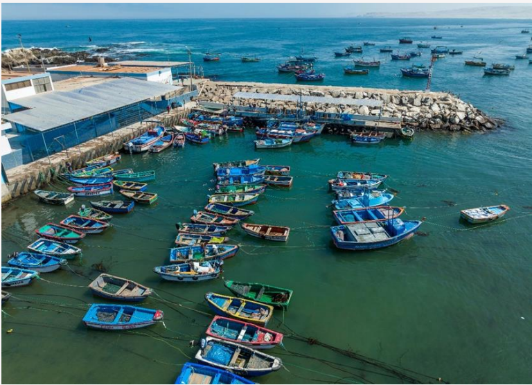
Fotografía 44: Infraestructura existente y en funcionamiento
