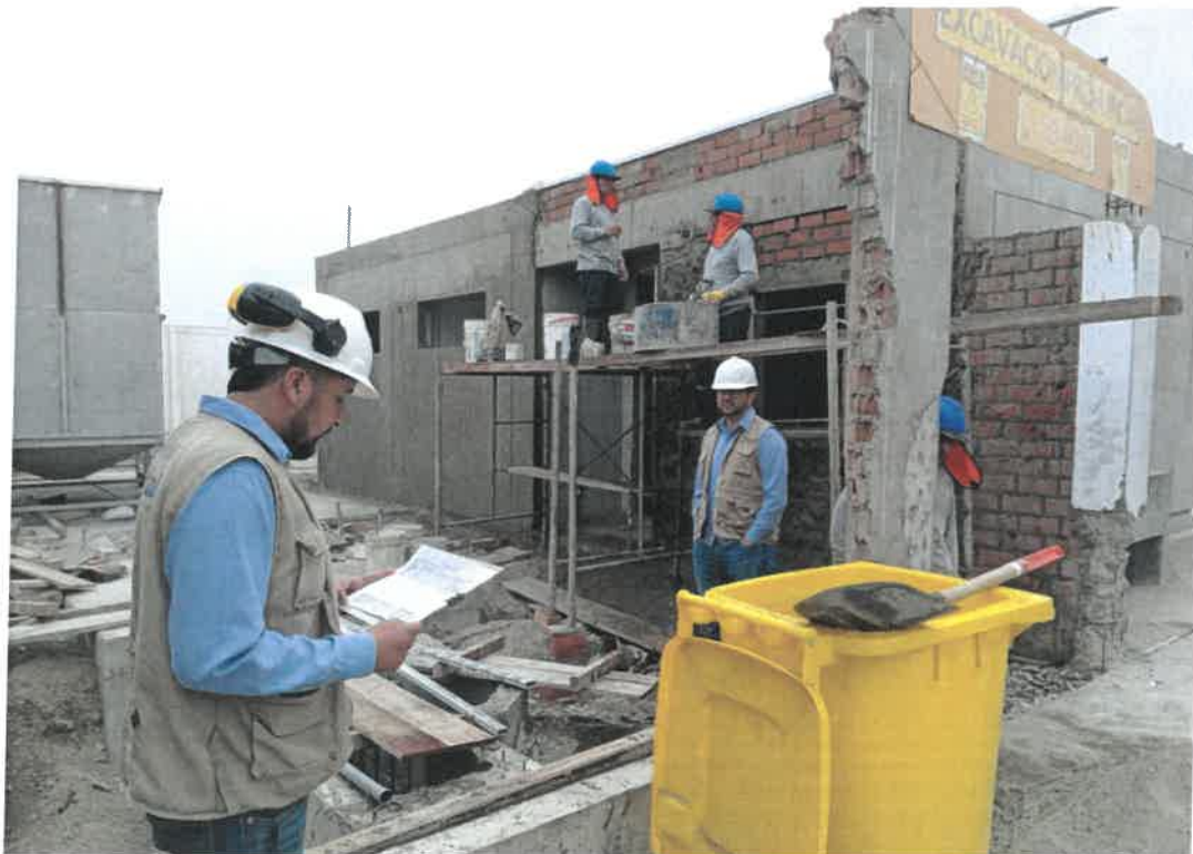
Ilustración 4: Trabajos de supervisión en el área de PTAR - Trabajos de tarrajeos en muros exteriores.
