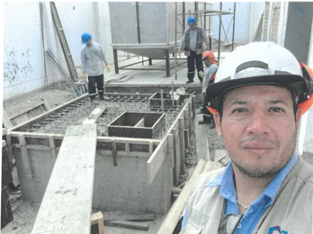
Ilustración 6: Supervisión de vacados de concreto en estructuras sanitarias - AREA PTAR.
