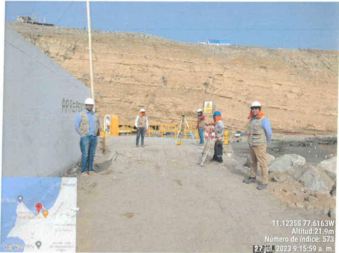
Ilustración 9: Equipo de supervisión, verificación de toma de niveles en exteriores del DPA - Acceso a muelle
