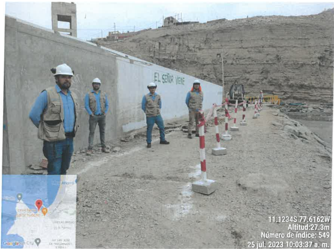
Ilustración 11: Equipo de supervisión en exteriores del DPA, movimiento de tierras.
