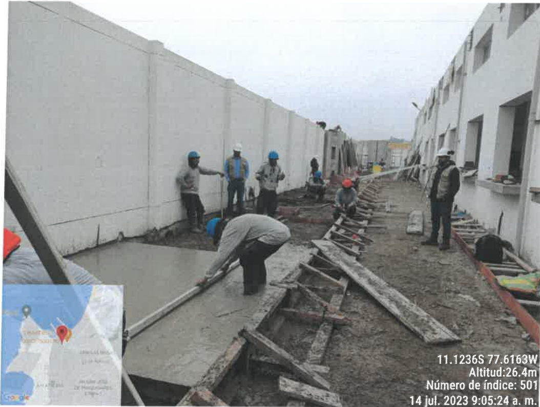
Ilustración 15: Supervisión en el vaciado de concreto f_c=280\text{kg/cm}^2 en piso de área de descarga de materia prima.
