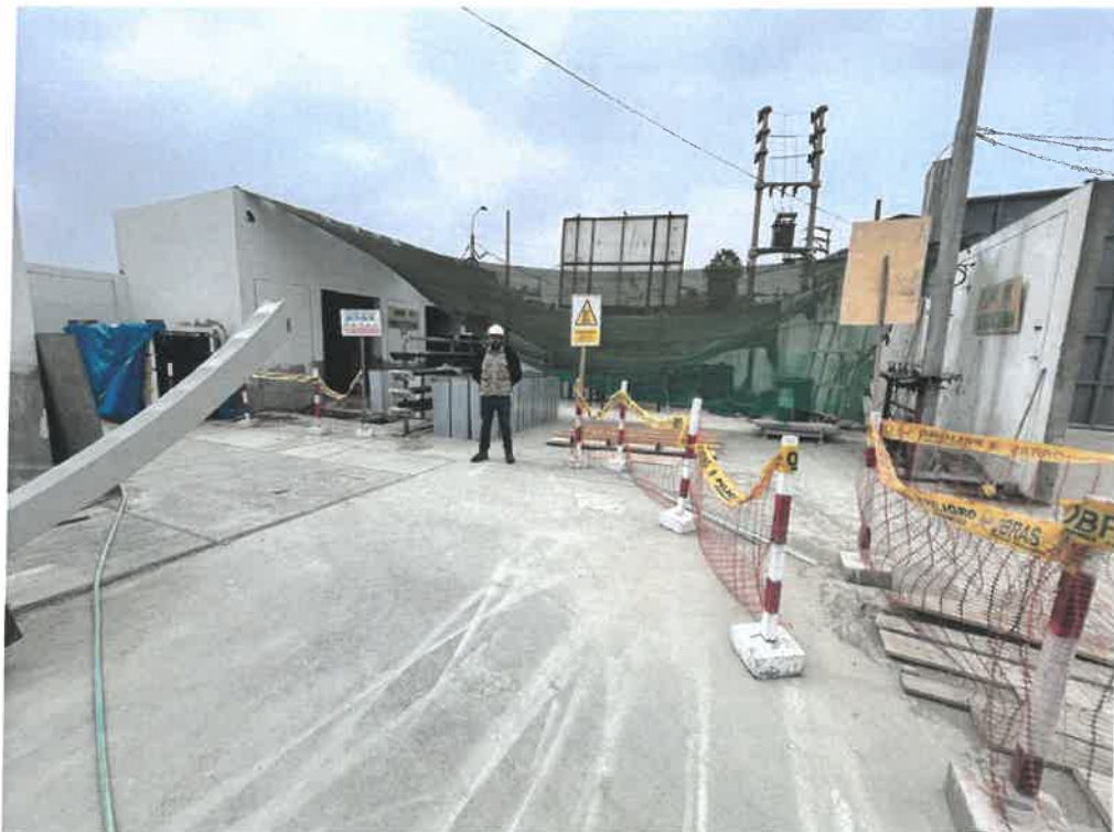
Ilustración 8: Implementación de señalización en obra.
