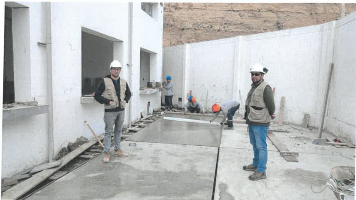
Ilustración 16: Trabajo de acabado pulido en piso de área de descarga de materia prima.
