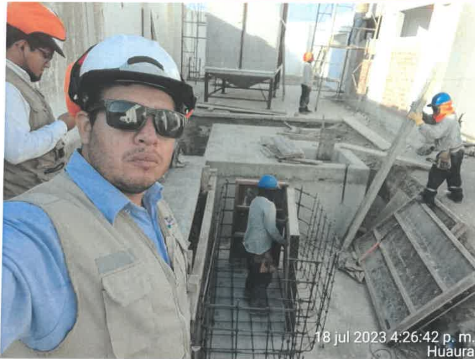
Ilustración 17: Supervisión de armadura y encofrado para cámara de rejás - Estructura sanitarias.
