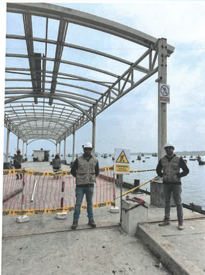
Ilustración 13: Implementación de señalización en obras de mar – cabezo de muelle.
