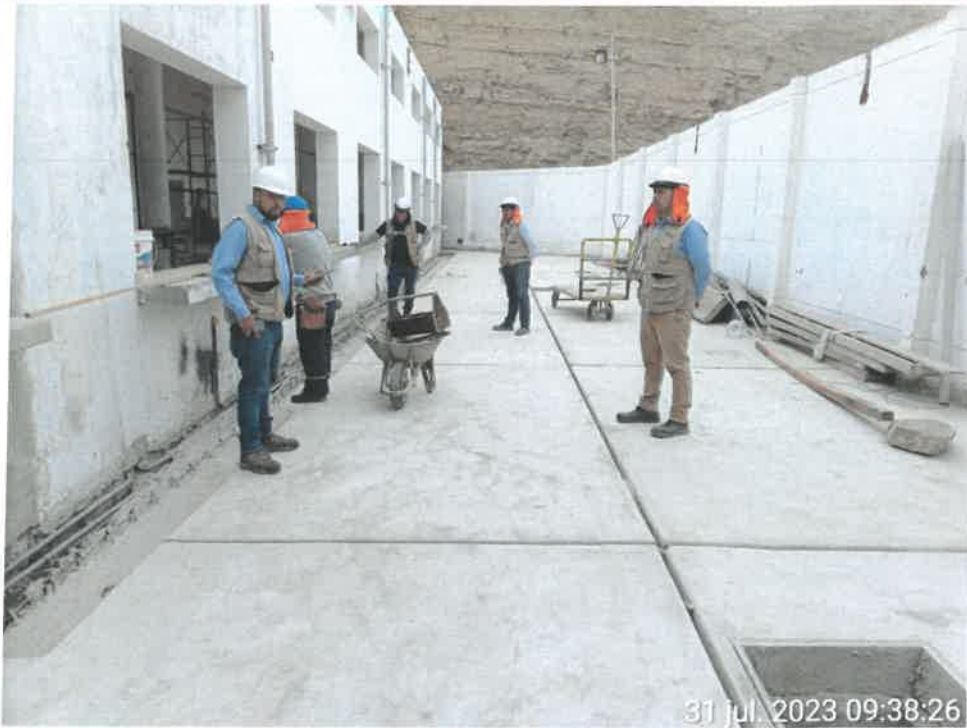
Ilustración 7: Equipo de supervisión verificando trabajos de canaletas en área de descarga de materia prima.
