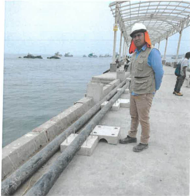
Ilustración 5: Supervisión de colocación de lastre tubería HDPE.
