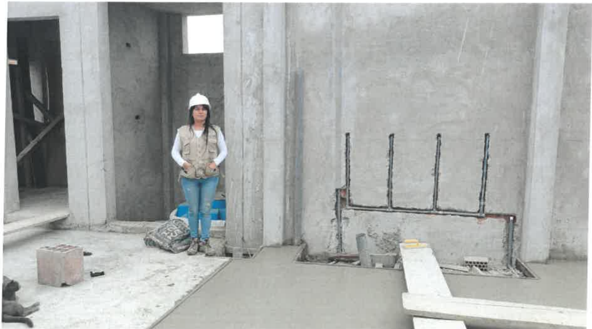
Ilustración 10. Supervisor Especialista en sanitarias, verificación de tuberías de desague.
