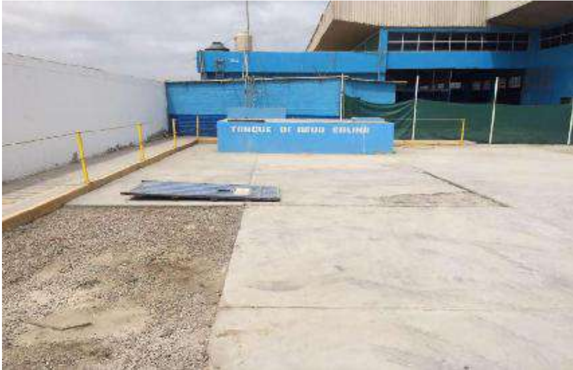
FOTO N°. 05 VISTA FOTOGRAFICA DE LA SITUACION ACTUAL DEL TANQUE CISTERNA Y AREA ADYACENTE A ELLA.
