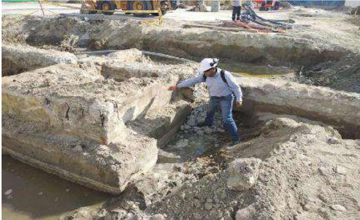
FOTO No. 13 TOMA FOTOGRAFICA DEL AREA DONDE SE EDIFICARA EL BLOQUE " A" , EL ESPECIALISTA EN ESTRUCTURA DE LA SUPERVISION INSPECCIONANDO EL LUGAR, DONDE SE ENCUENTRA LA CIMENTACION DE UNA EDIFICACIONES EXISTENTES.
