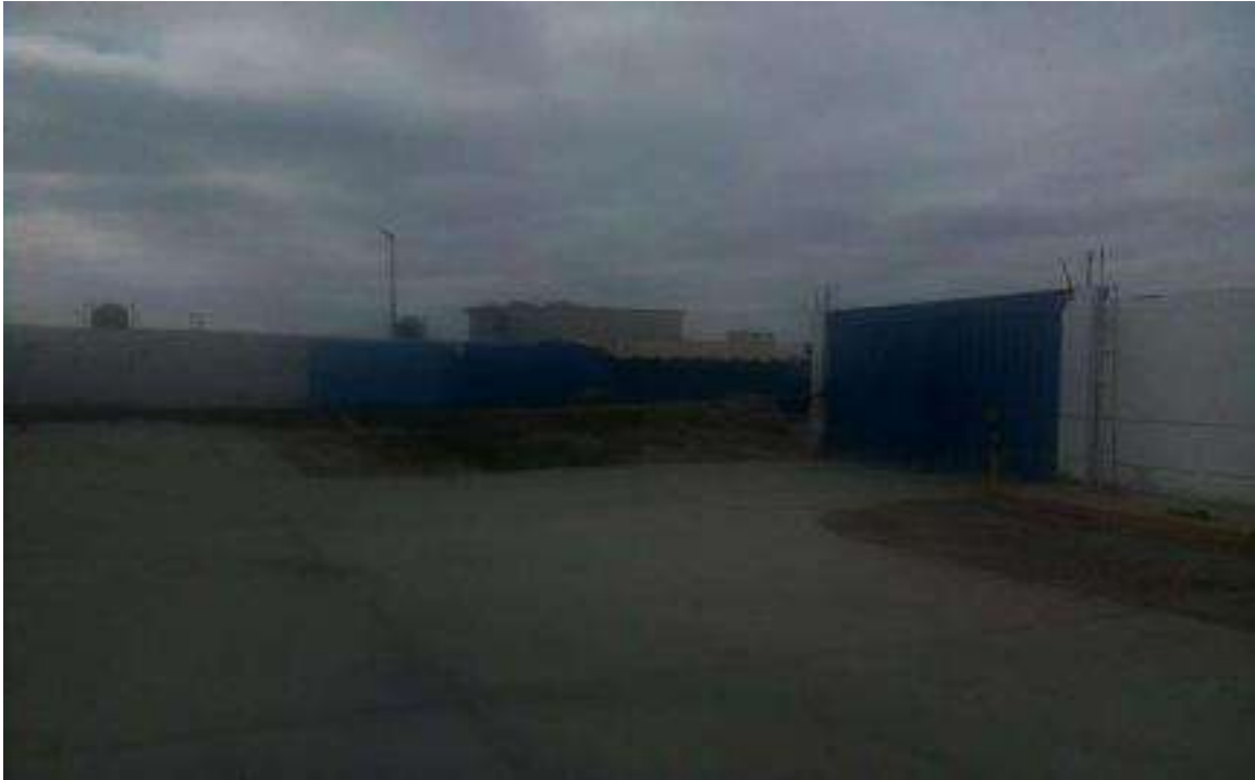
FOTO No. 05 VISTA FOTOGRAFICA DE LA SITUACION ACTUAL DEL INGRESO PRINCIPAL AL TPZ PARACHII QUE
