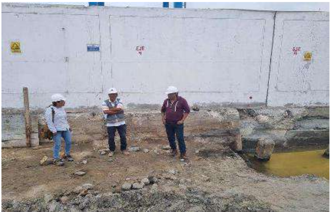
FOTO No. 10 OMA FOTOGRAFICA EN EL AREA DONDE SE EDIFICARA EL BLOQUE "B" CON PRESENCIA DE LA ING. LIZHET ROXANA RDRIGUEZ NEYRA. COORDIADORA DE OBRA - FONDEPES.
