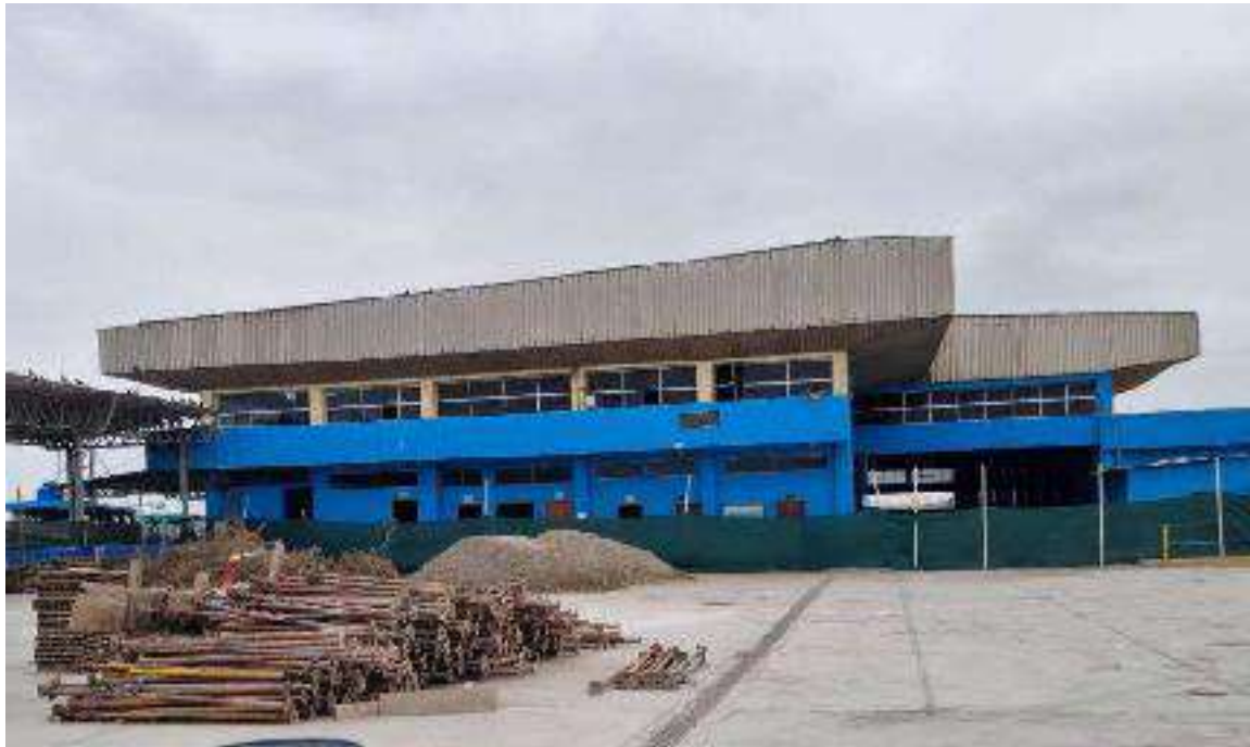
FOTO No. 03 VISTA FOTOGRAFICA DE MATERIALES INSUMOS PARA ENCOFRADO Y DESENCOFRADO, PUESTOS EN OBRA.
