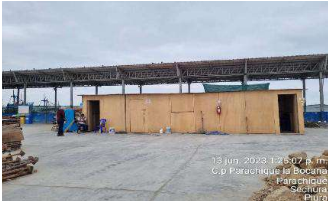
FOTO No. 01 INSTALACIONES DE LA OFICINA Y ALMACEN DE OBRA
