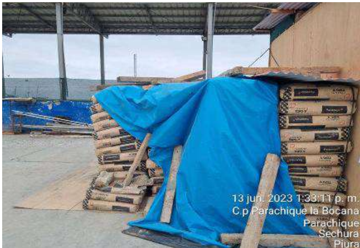
FOTO No. 02 VISTA FOTOGRAFICA DE BOLSAS DE CEMENTO EN OBRA.
