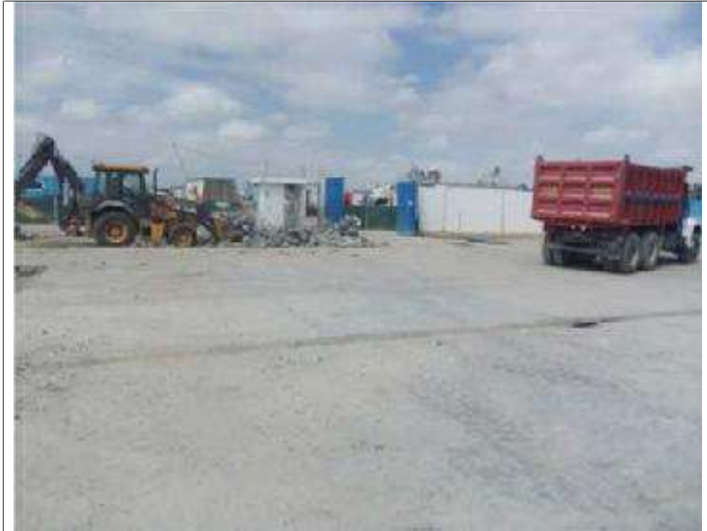
F27: Eliminación de material excedente, con Retroexcavadora y Volquete de V=15m3.
