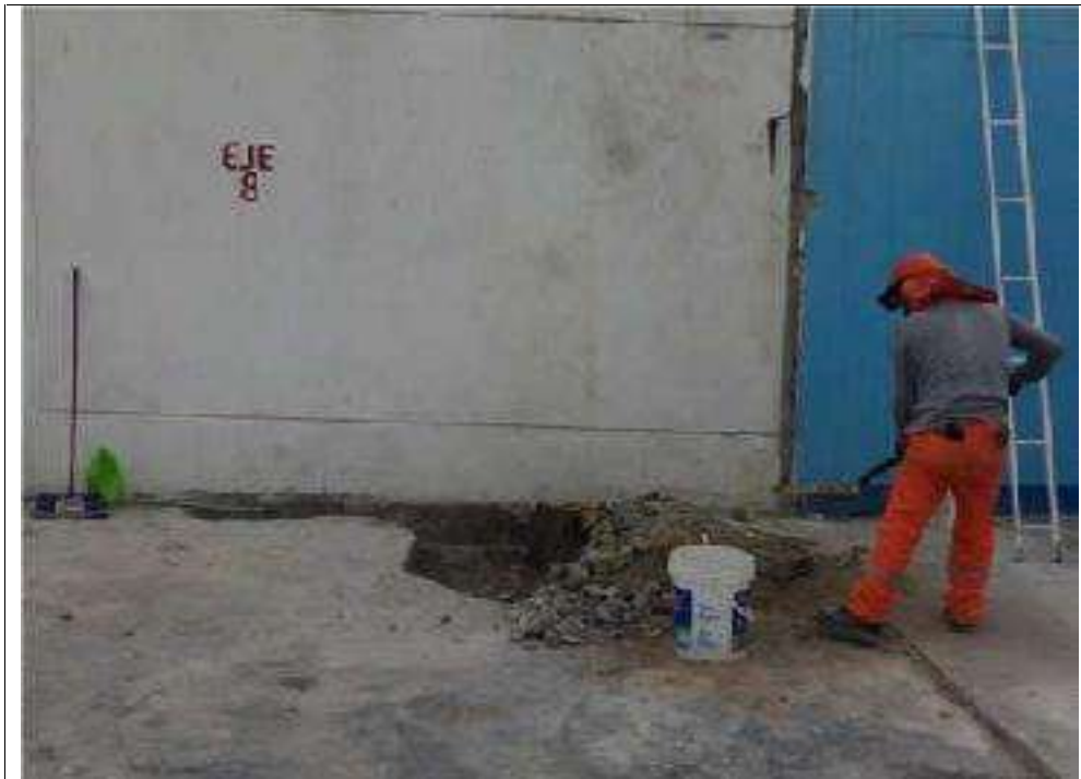
F15: Excavación de Calicata, con fines de constatación de suelo.
