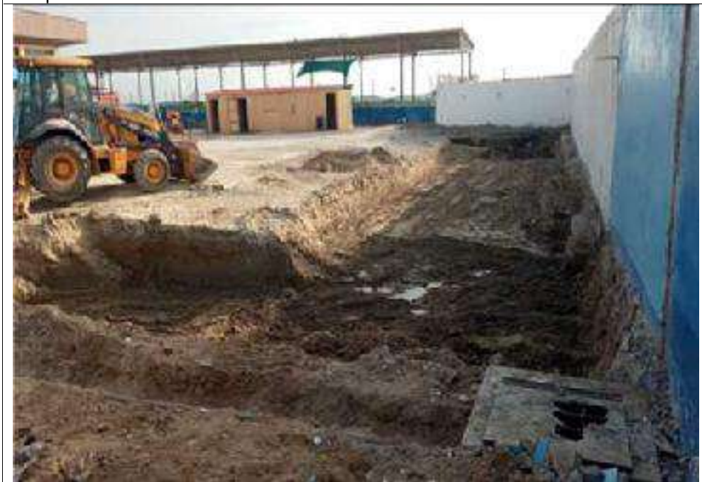
F30: Excavación y eliminación masiva en los Bloques "A" y "B", con retroexcavadora y Volquete de V=15 m3.
