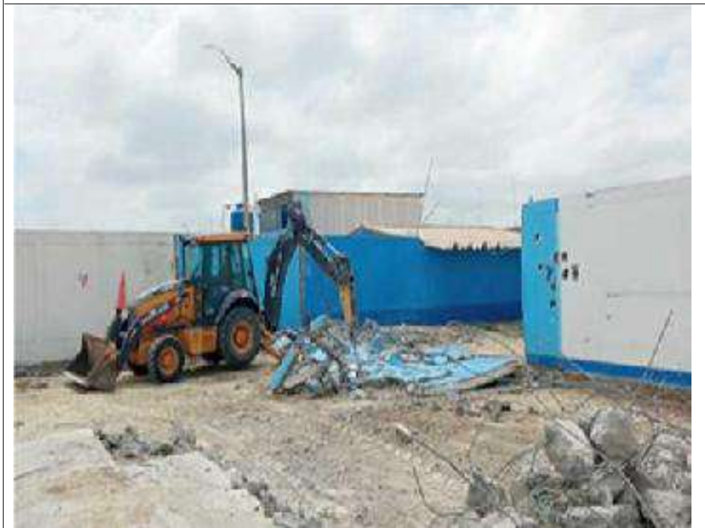
F24: Demolición de Cerco Perimétrico, con Retroexcavadora y martillo.
