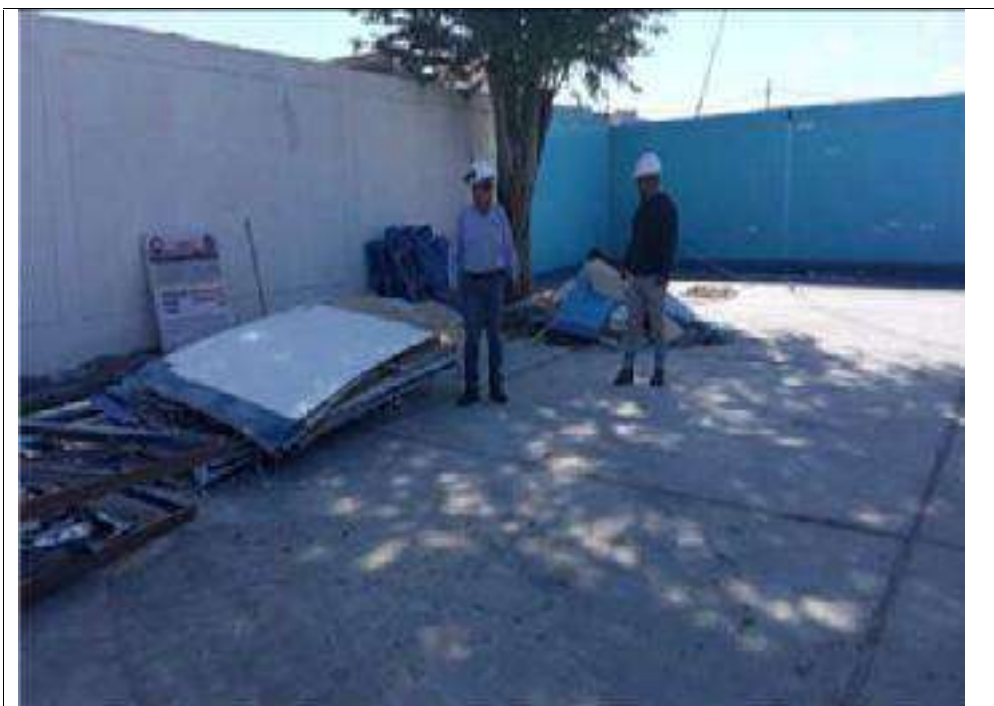
F1: Desmontajes de Tabiquería Drywall y Puertas.
