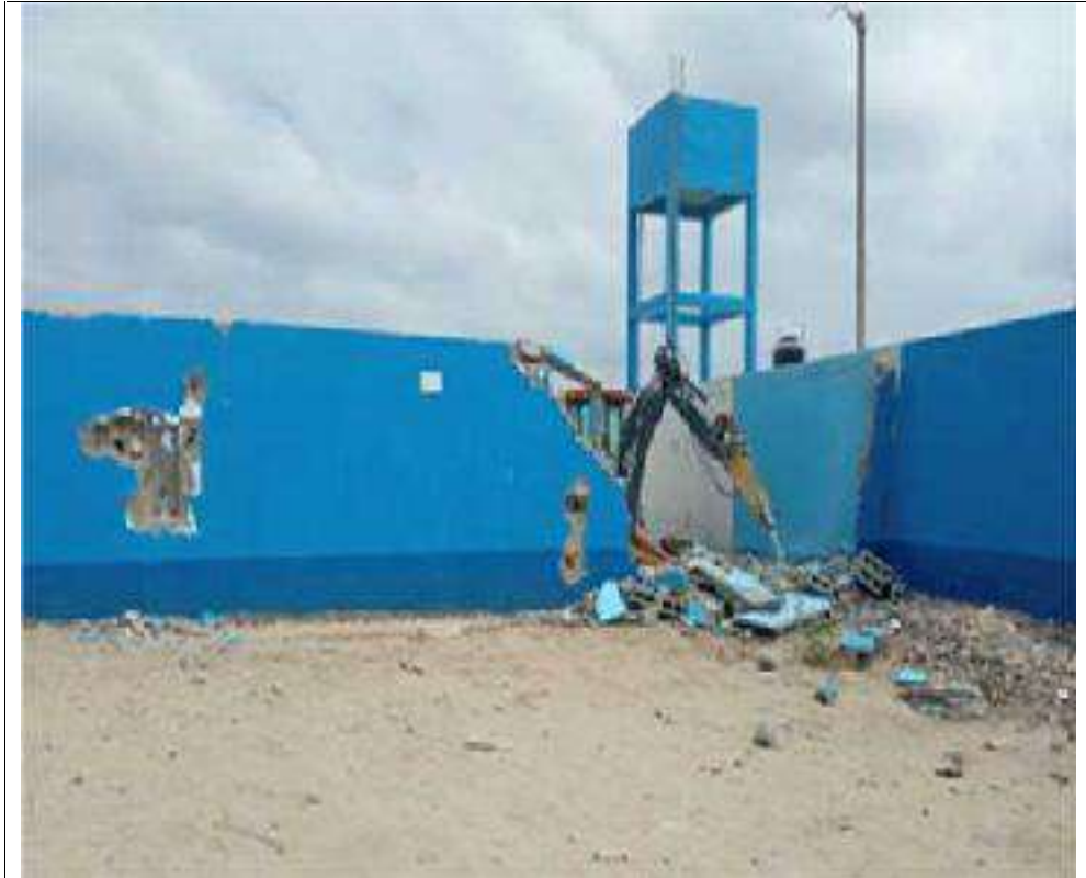
F25: Demolición de Cerco Perimétrico, con Retroexcavadora y martillo.
