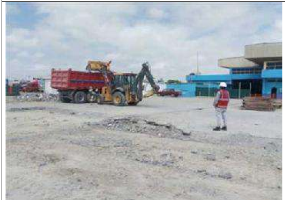
F28: Eliminación de material excedente, con Retroexcavadora y Volquete de V=15m3.
