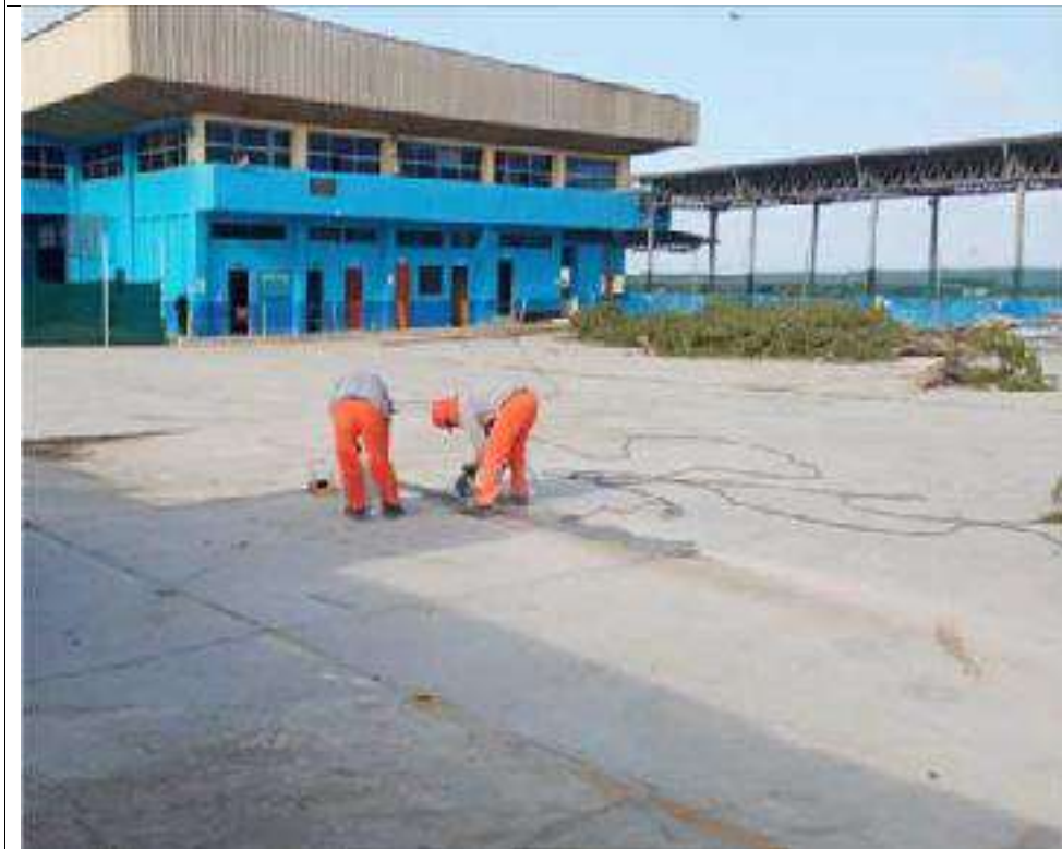
F10: Corte de losa de concreto armado.
