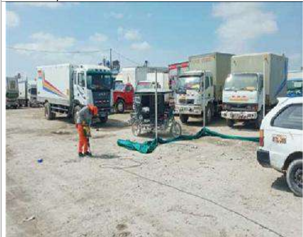
F4: Instalación de Cerco Perimétrico Provisional.
