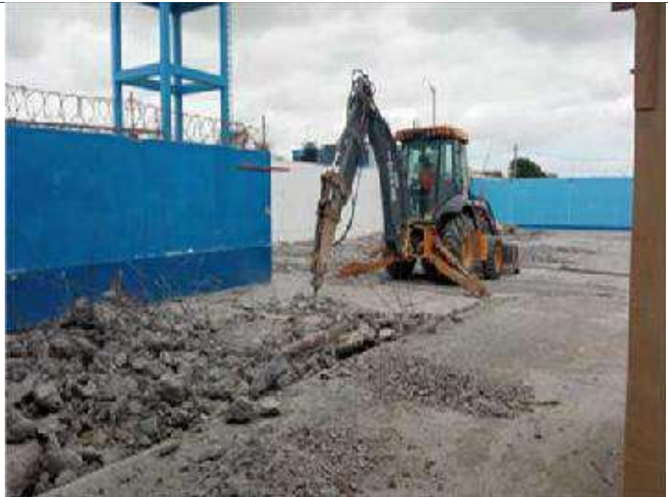
F22: Demolición de losa en bloque "B" (SS. HH. y VESTIDORES), se usa Retroexcavadora con martillo.
