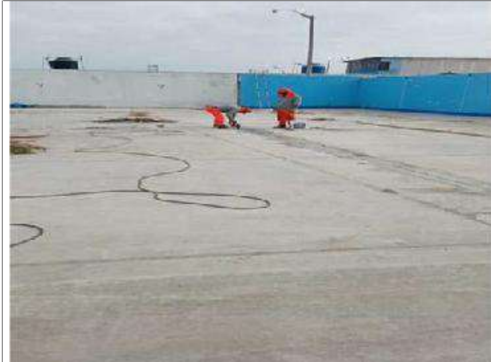
F9: Corte de losa de concreto armado.
