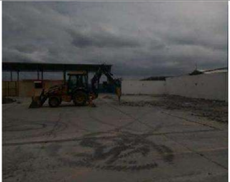
F19: Demolición de losa en bloque "B" (SS. HH. y VESTIDORES), se usa Retroexcavadora con martillo.
