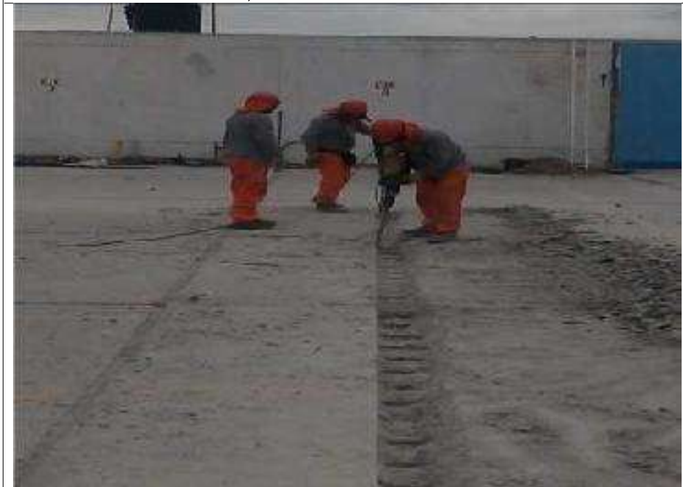
F16: Demolición de los bordes de la losa de concreto armado, en zona de ALMACENES – ADMINISTRACION.
