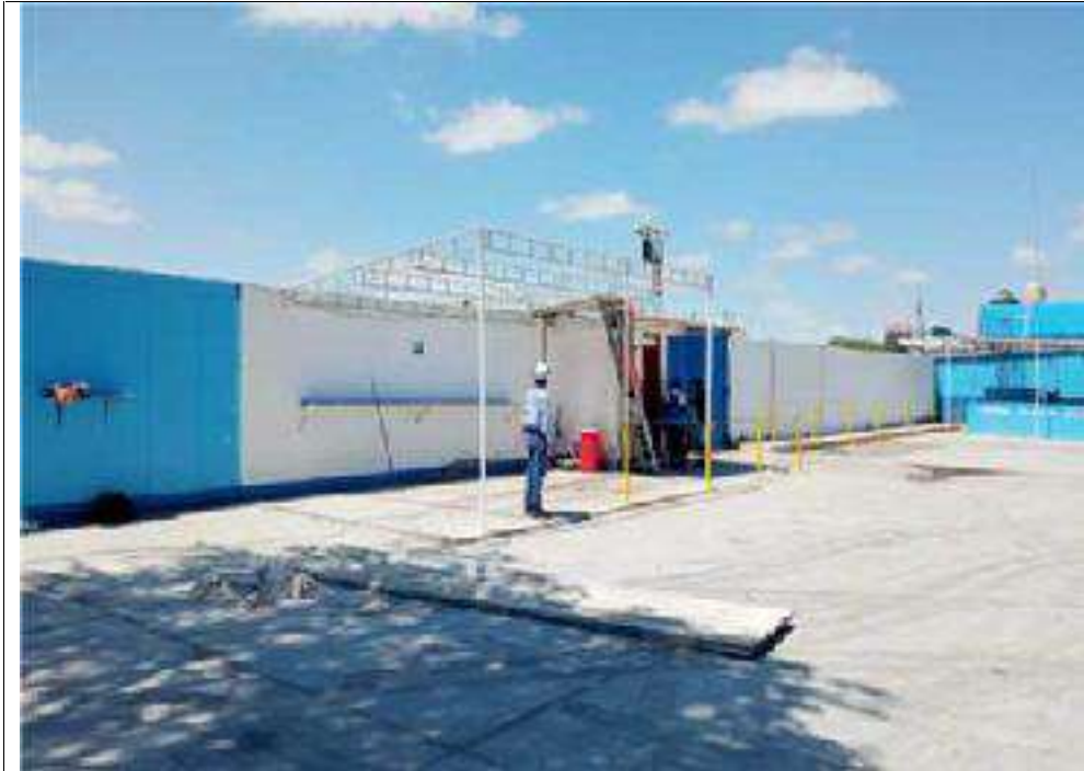
F3: Desmontaje de Estructura metálica.
