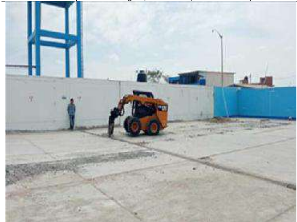
F18: Demolición de losa con Bobcat con martillo.
