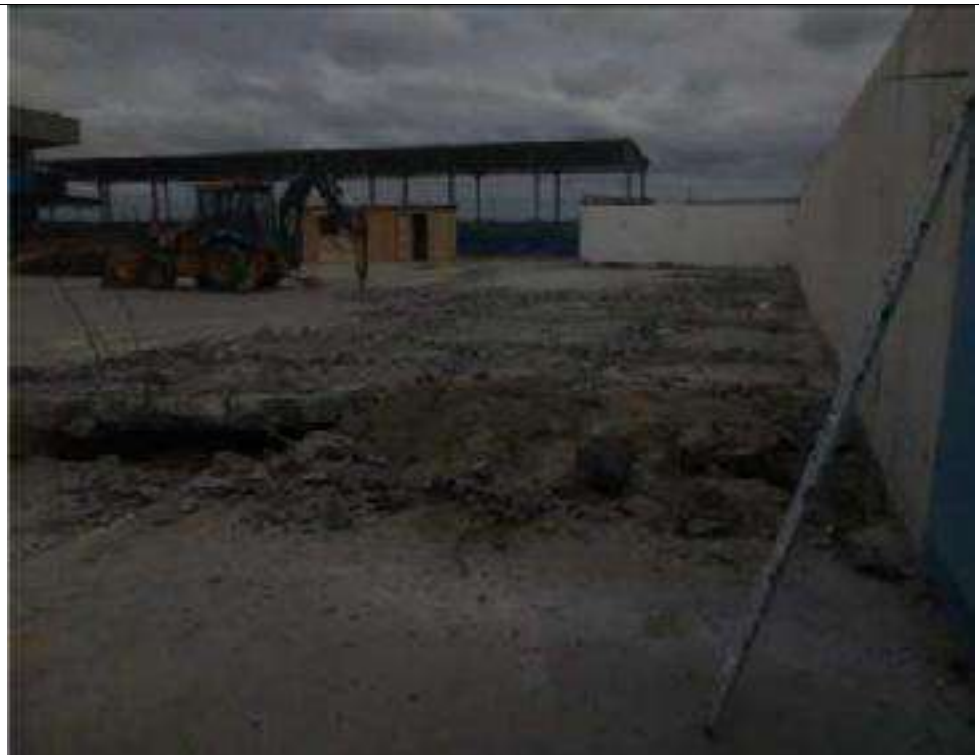
F20: Demolición de losa en bloque "B" (SS. HH. y VESTIDORES), se usa Retroexcavadora con martillo.
