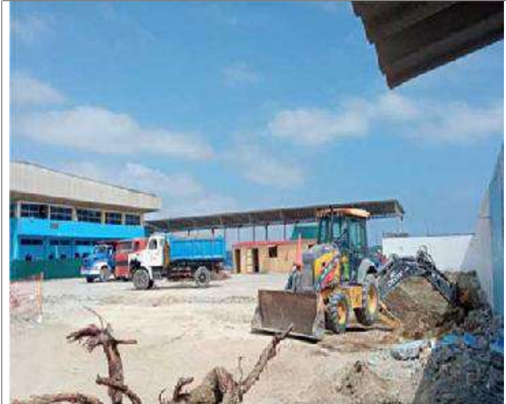
F29: Excavación y eliminación masiva en Bloque "B", con retroexcavadora y Volquete de V=15 m3.
