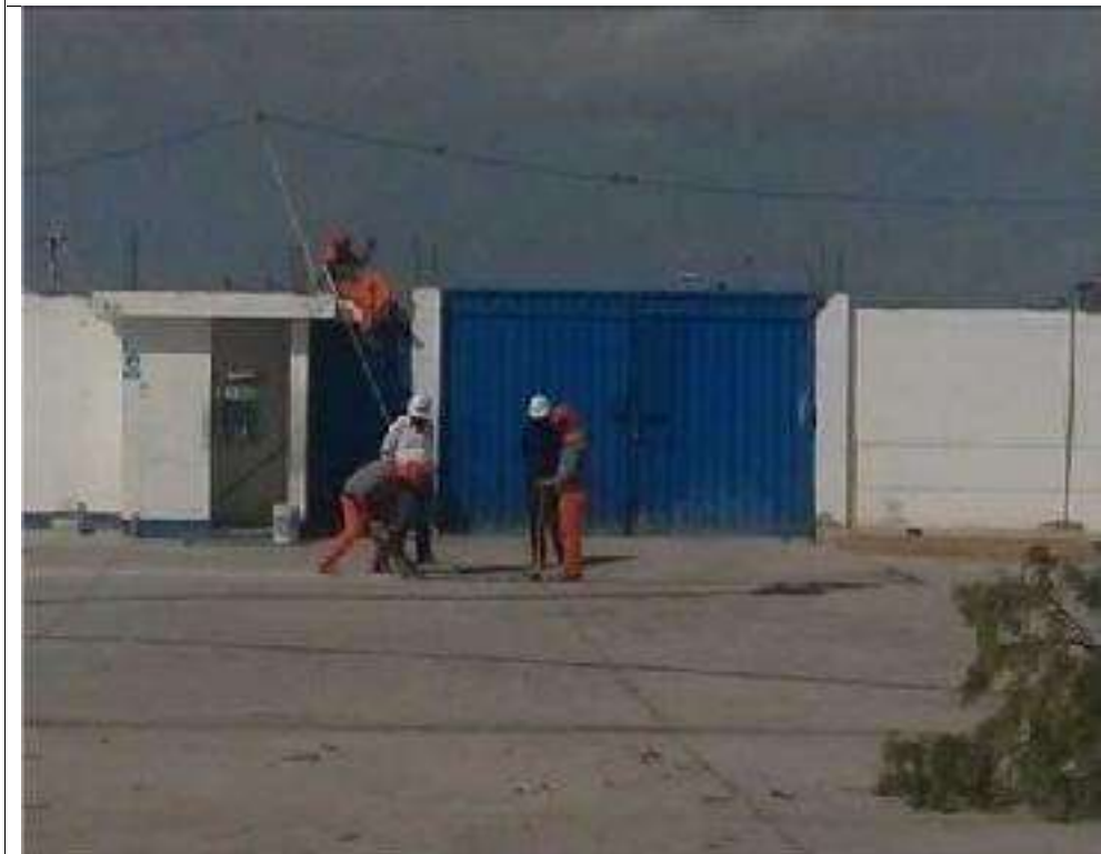
F14: Demolición de viga de cerco y bordes de la losa de concreto.
