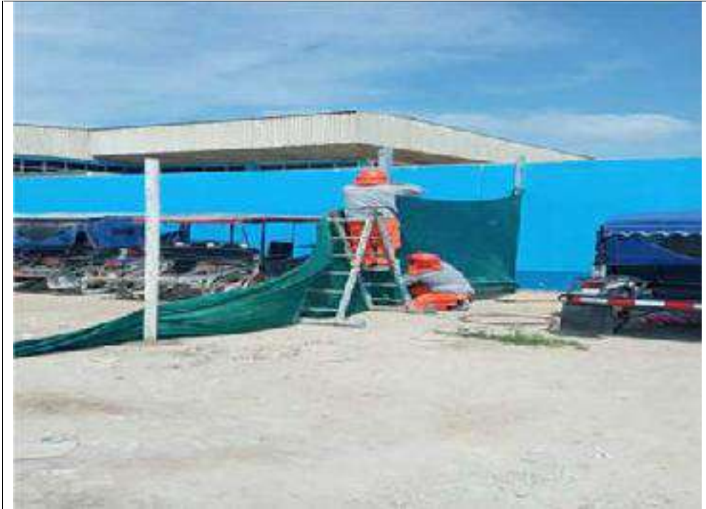
F5: Instalación de Cerco Perimétrico Provisional.
