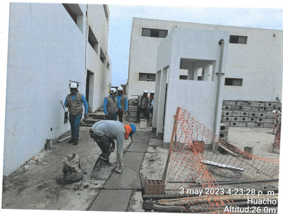
Ilustración 5: Supervisión de los trabajos de pulido en veredas.
