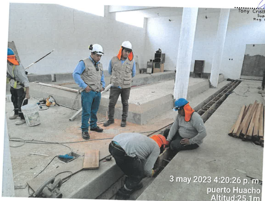
Ilustración 4: Supervisión del encofrado en canaletas, dentro del área de fríos.
