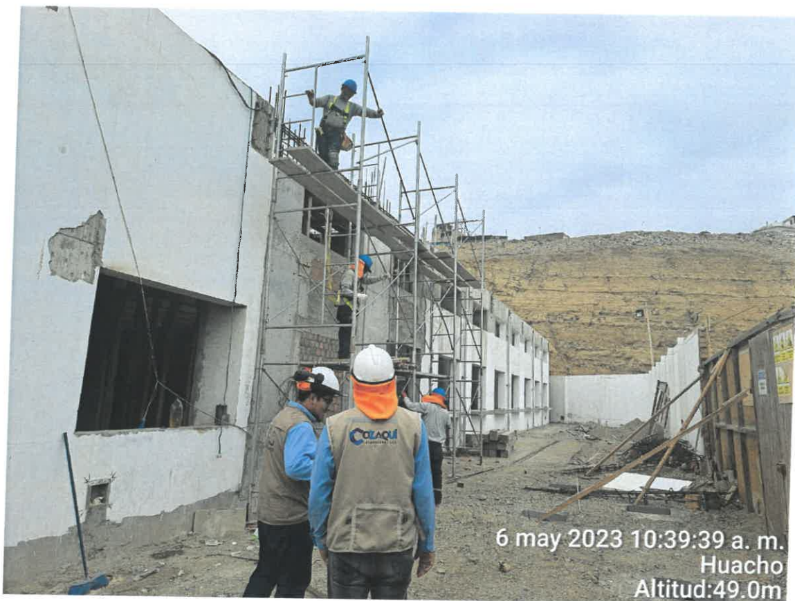
Ilustración 9: Supervisión de trabajos en altura (Tarrajeo de muros exteriores en tareas previas).
