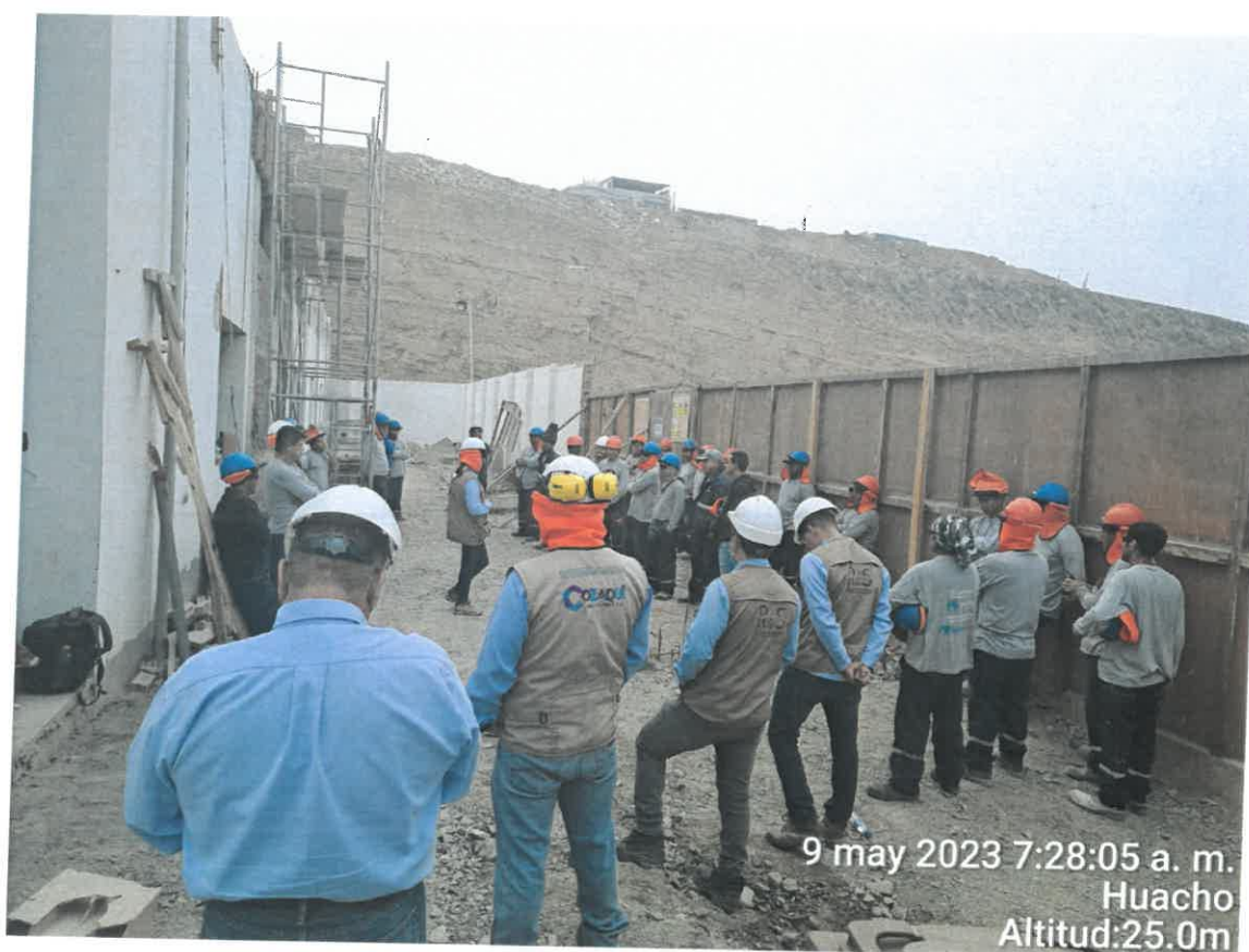
Ilustración 12: Charla de seguridad en presencia del residente, especialistas del contratista y supervisión, junto al personal obrero.
