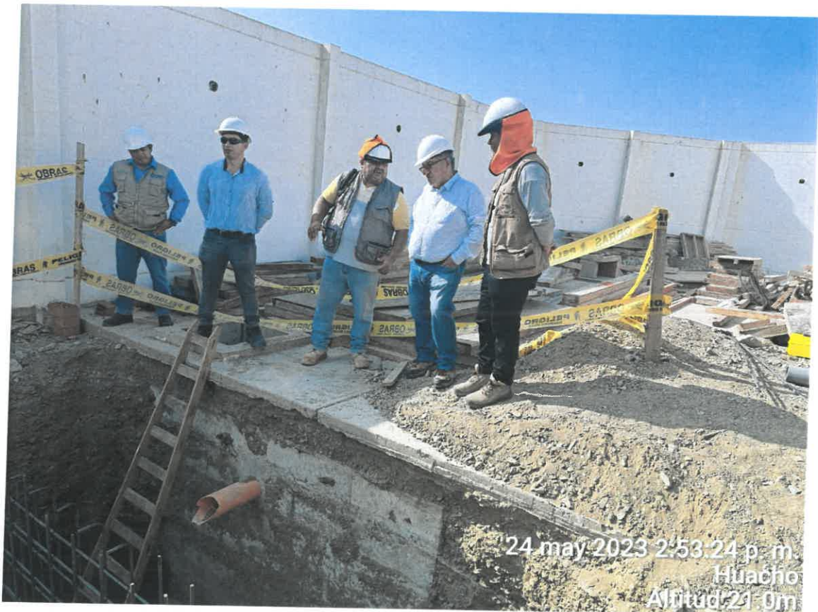
Ilustración 20: Coordinaciones en campo, residencia con supervisión en el área de P.A.R.
