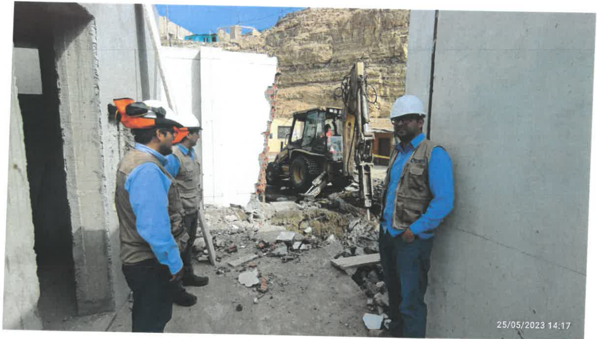
Ilustración 21: Supervisión de los trabajos de demolición en el área de desinfección.
