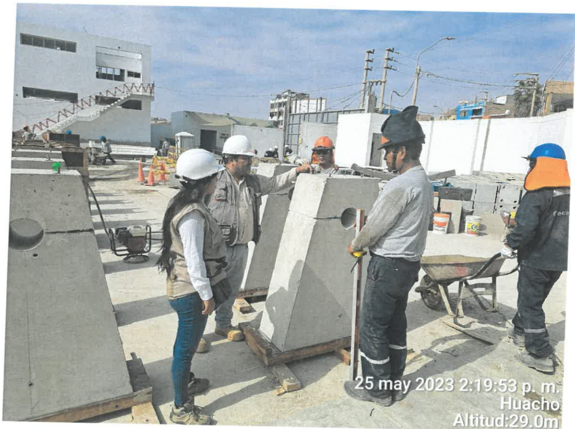
Ilustración 22: Verificación de lastres tipo II, con la especialista en Sanitarias.
