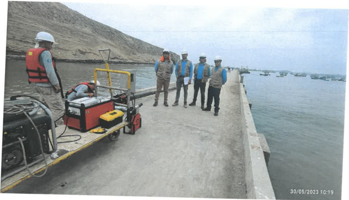
Ilustración 23: Supervisión de los trabajos de termofusión en las tuberías HDPE - Obras de mar.
