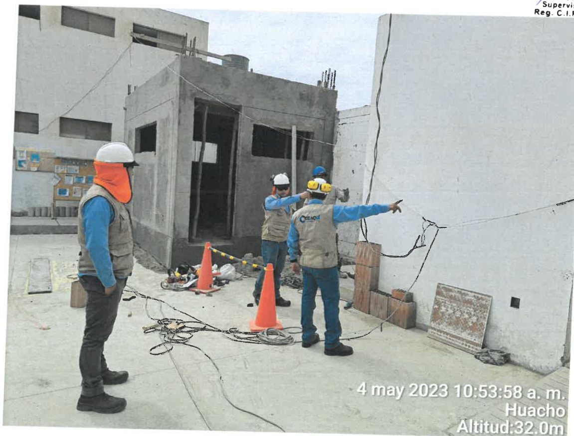
Ilustración 6: Supervisión de los trabajos de tarrajeo en el área de tópic.
