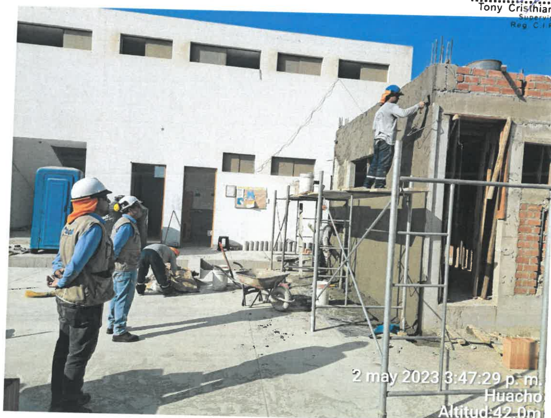
Ilustración 2: Supervisión de los trabajos de tarrajeo.
