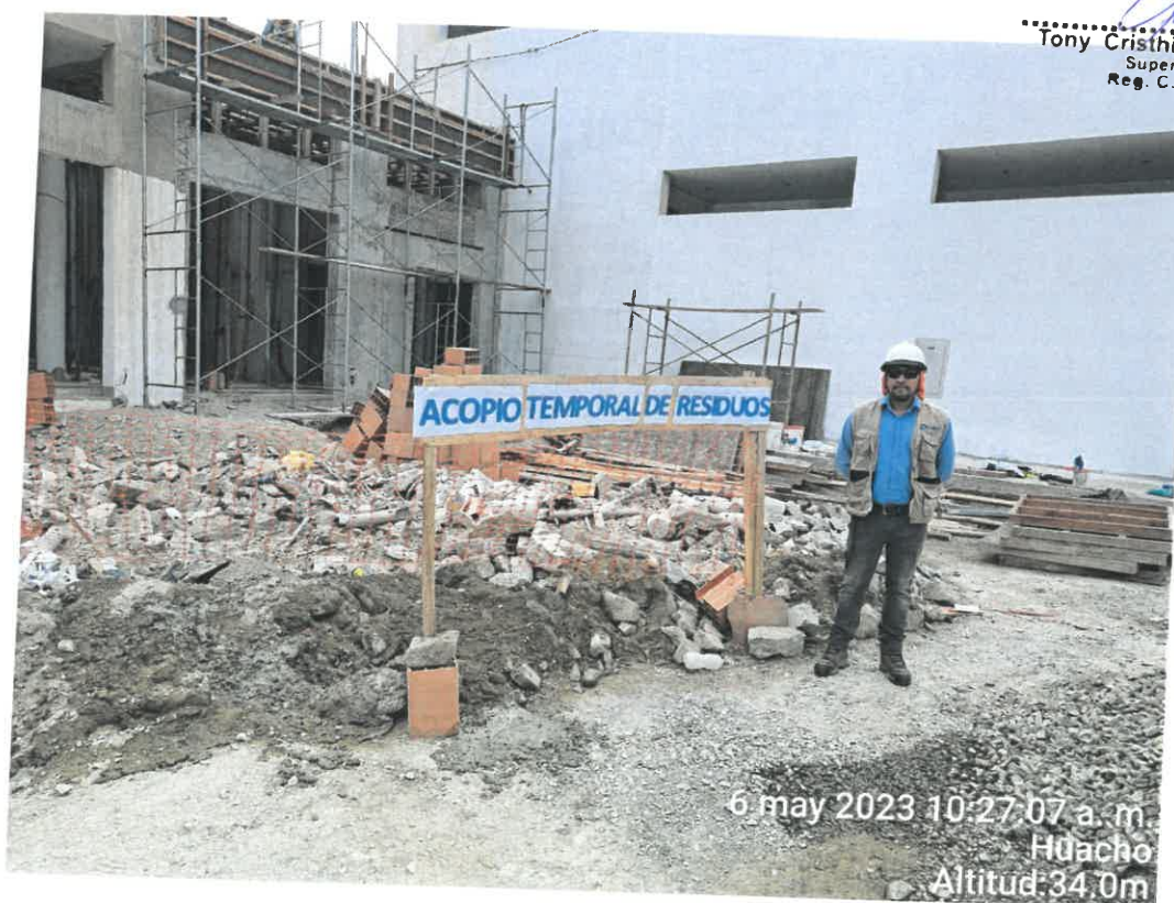
Ilustración 8: Supervisión de los lugares de acopio temporal de residuos, para mantener el orden y limpieza en la obra.
