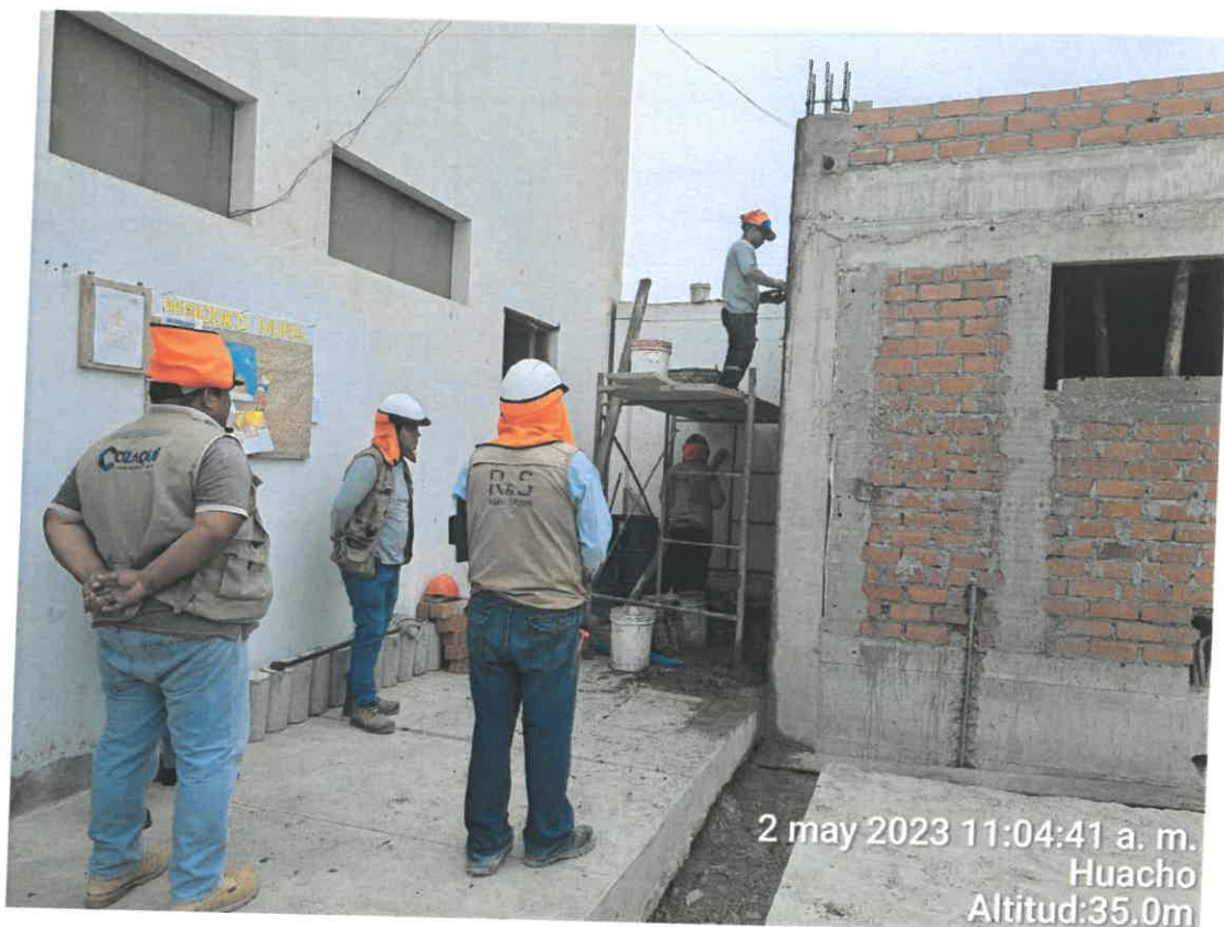
Ilustración 1: Verificación de obras civiles en el área de tópicó.
