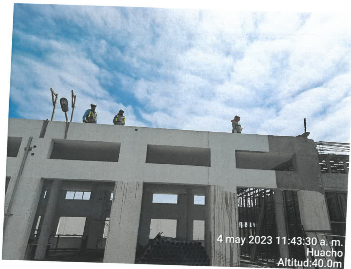
Ilustración 7: Equipo de supervisión verificando el estado actual del techo en tareas previas, donde se realizará la ampliación de losa aligerada.
