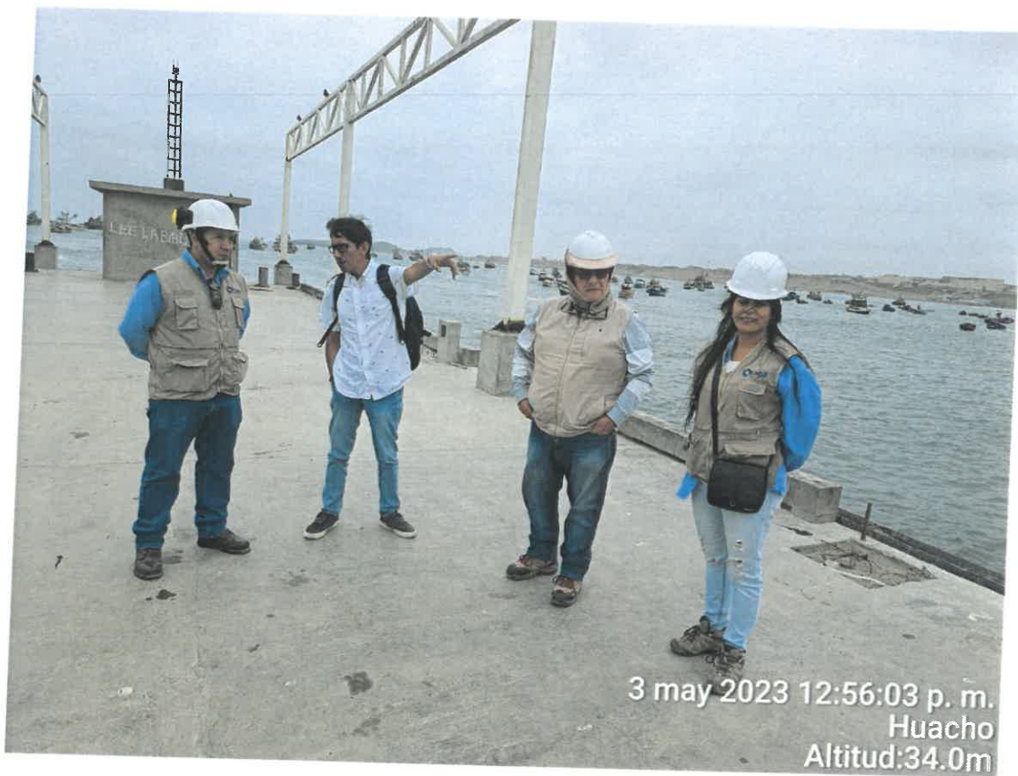
Ilustración 3: Visita del coordinador de obra, Arq Edgar Vargas Aguilar. En presencia del residente de obra y la especialista supervisor Sanitaria.
