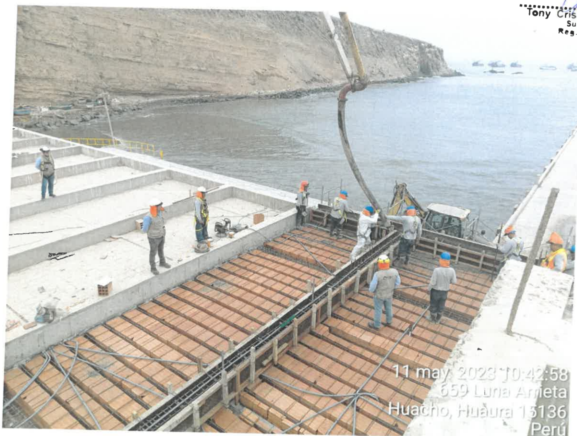
Ilustración 14: Supervisión del vaciado de concreto en losa aligerada en el área de TAREAS PREVIAS.
