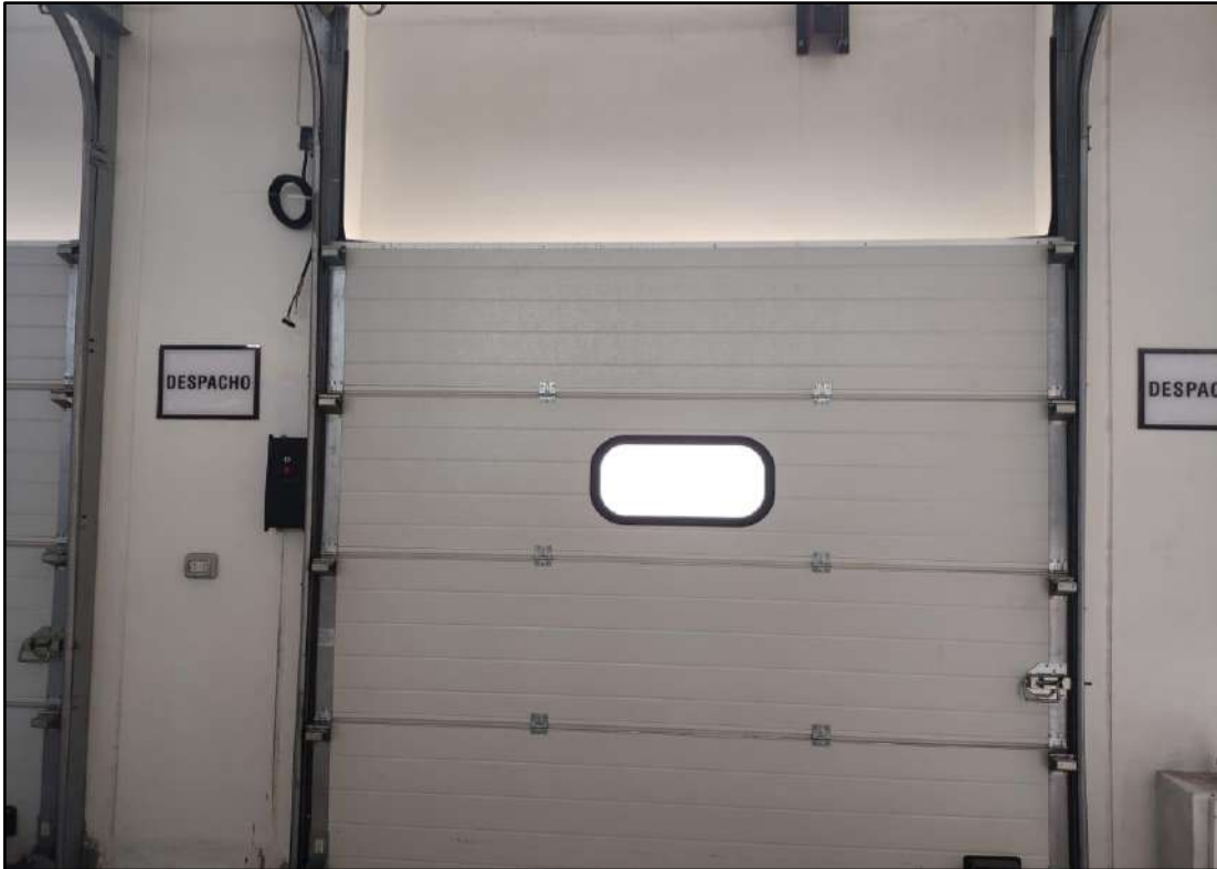
FOTO N° 01: Colocación del pulsador y funcionamiento de las puertas seccionales
