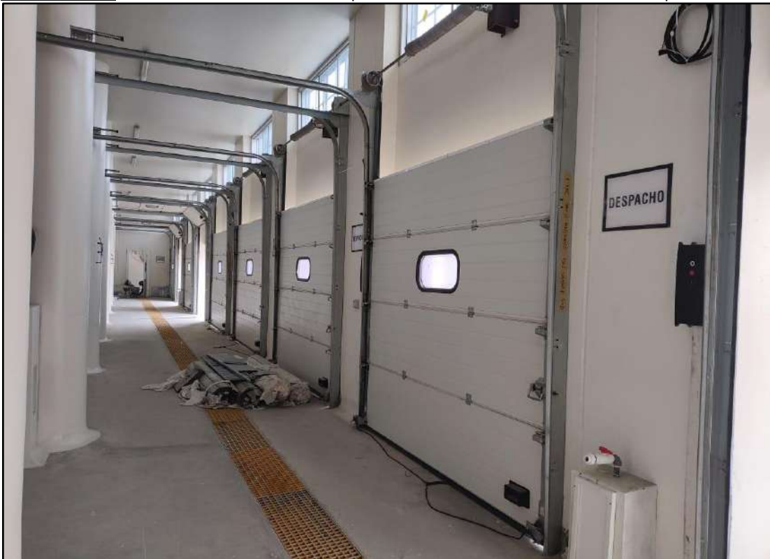
FOTO N° 04: Vista panorámica de puertas seccionables en tareas previas.
