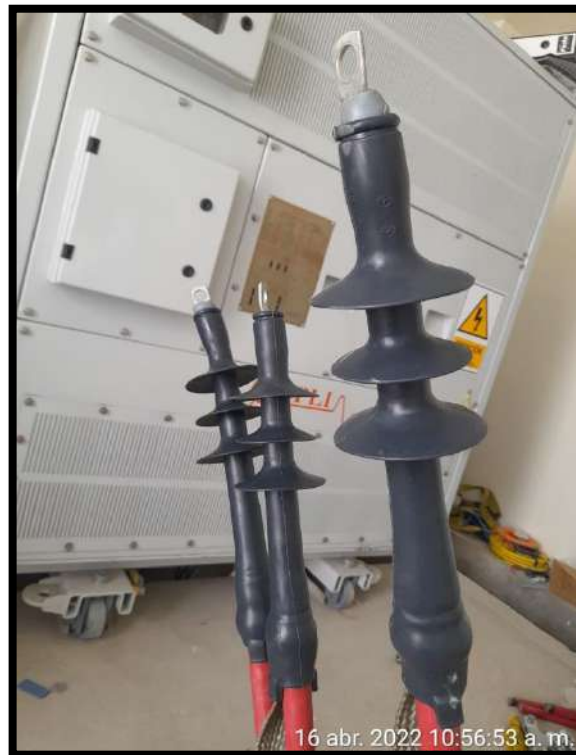
FOTO N° 4 : Instalación de Terminales
