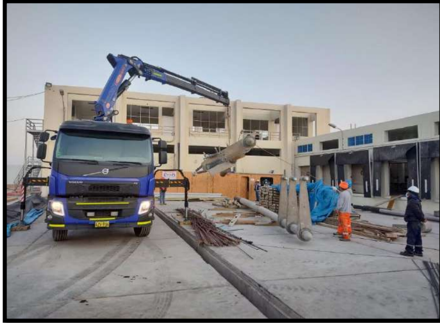
FOTO N° 1 : Maniobras realizadas para el traslado del poste CAC.
