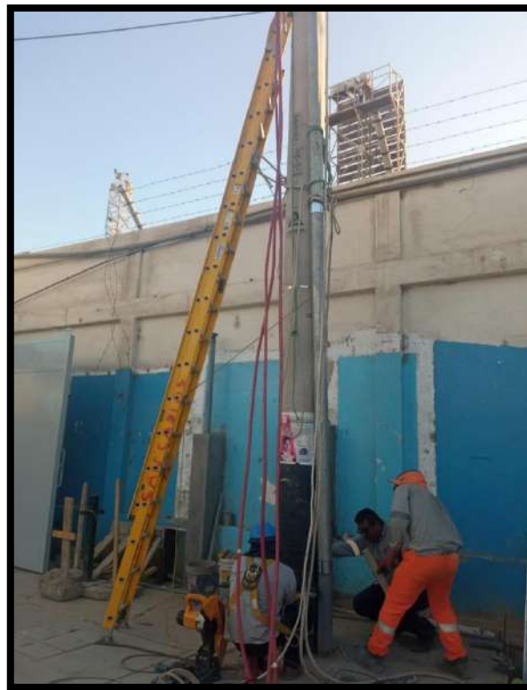
FOTO N° 6 : Suministro e instalación de ferretería eléctrica
