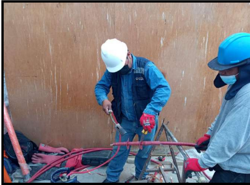
FOTO N° 3 : Suministro e instalación de Terminal Termocontraible.
