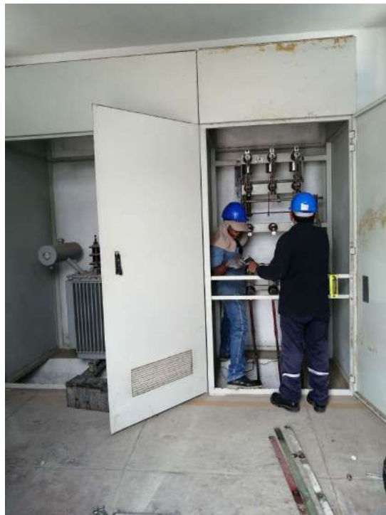
Desmontaje de Celdas MT existentes.
