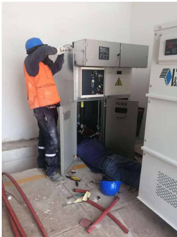
Montaje electromecánico de Celdas MT nuevas
