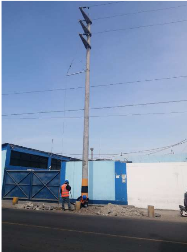
Trabajos en Poste de ingreso a Subestación.
