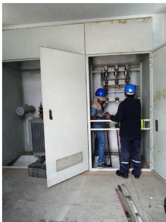
Desmontaje de Celdas MT existentes.
