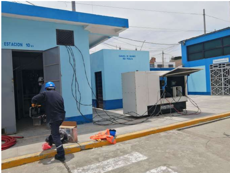
Instalación y Puesta en operación de Grupo Electrónico.
