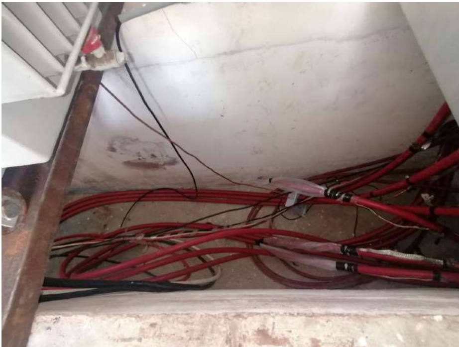
Limpieza de canales de cables
