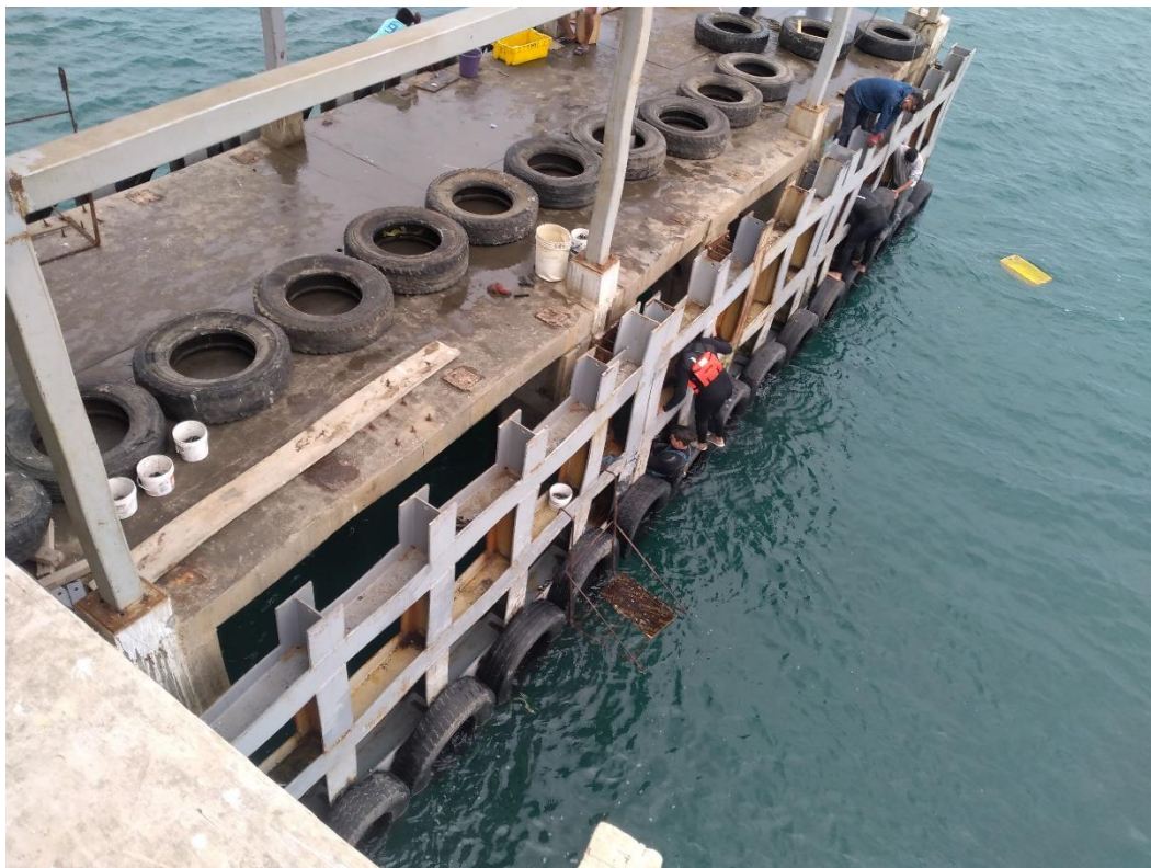
FOTO N° 06: INSTALACION DE NEUMATICOS LADO NORTE
