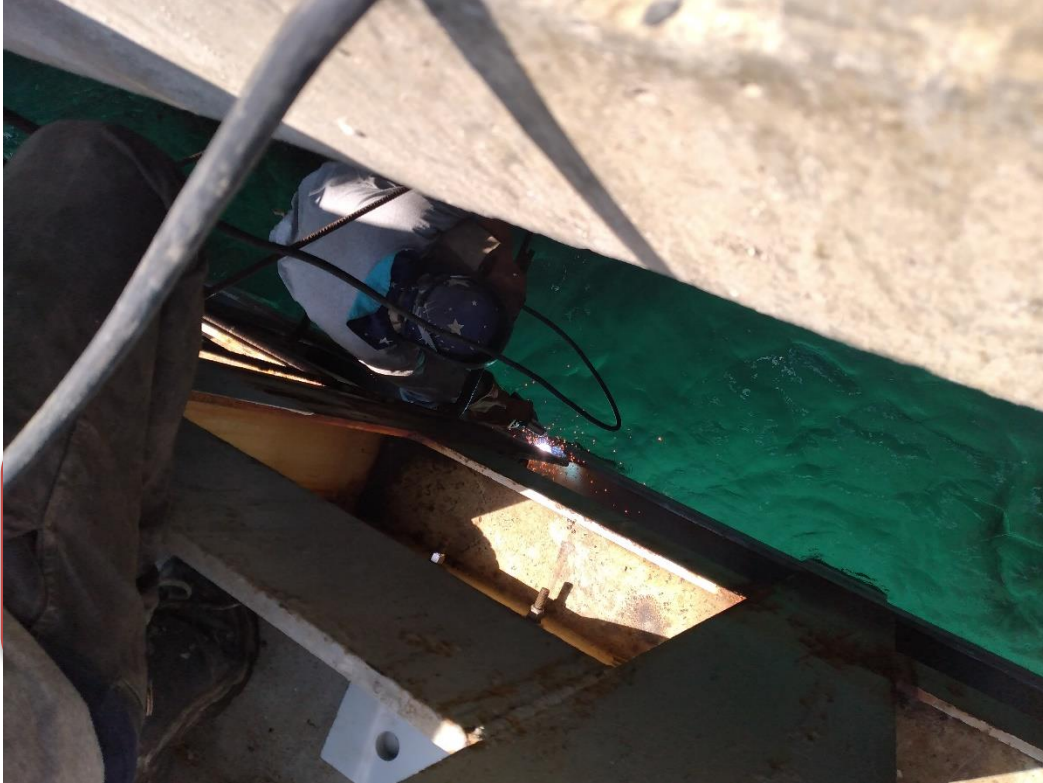
FOTO N° 01: SOLDADURA DE ESTRUCTURA DE VIGAS H LADO SUR
