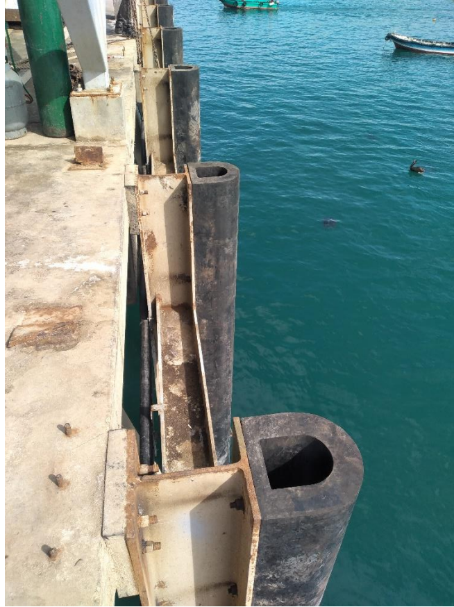
FOTO N° 07: INSTALACION DE DEFENSA TIPO D
