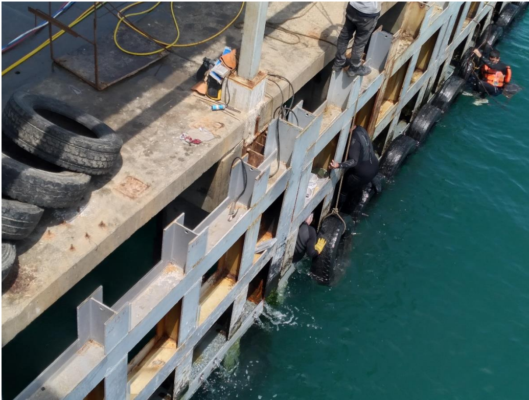
FOTO N° 05: PINTADO DE VIGAS Y COLOCACION DE LLANTAS LADO NORTE
