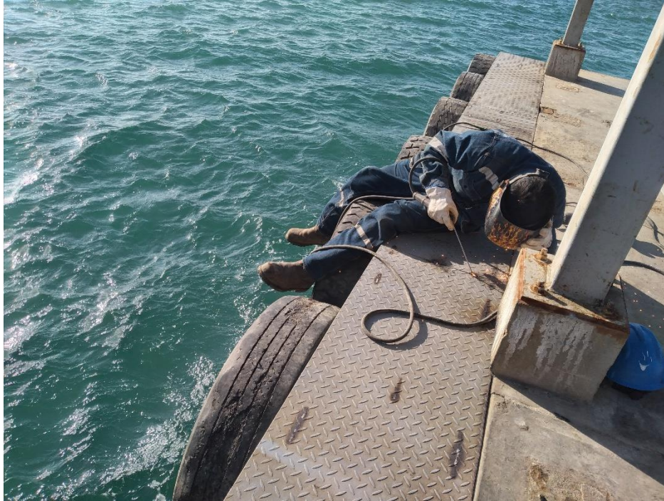
FOTO N° 09: REALIZANDO EL TRABAJO DE SOLDADURA EN LA PLATAFORMA METALICA ESTRIADA
