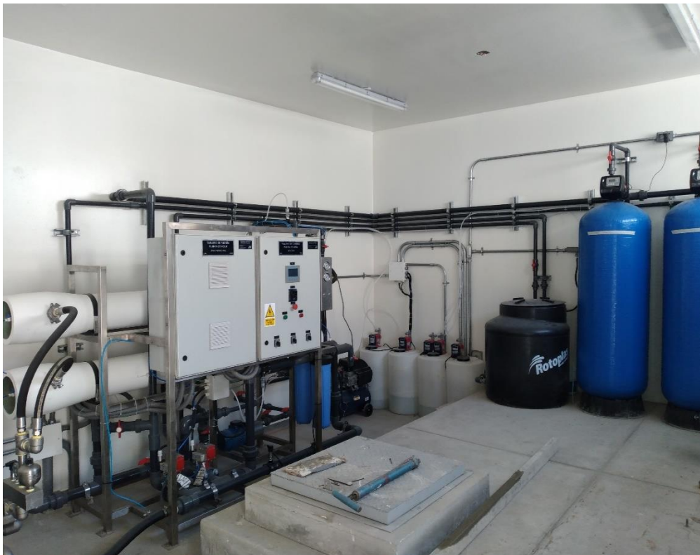
12.0 Se realizó el montaje de la planta de Osmosis-culminado al 100%
