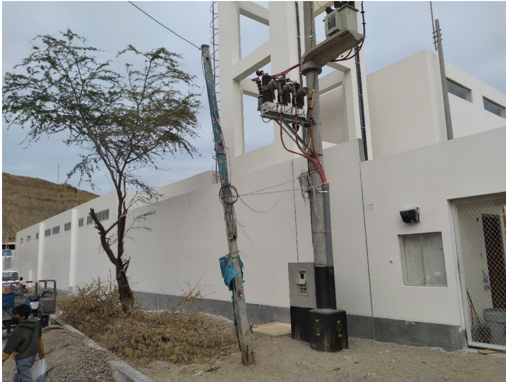
9.0 se culminó con el pintado de la fachada principal
