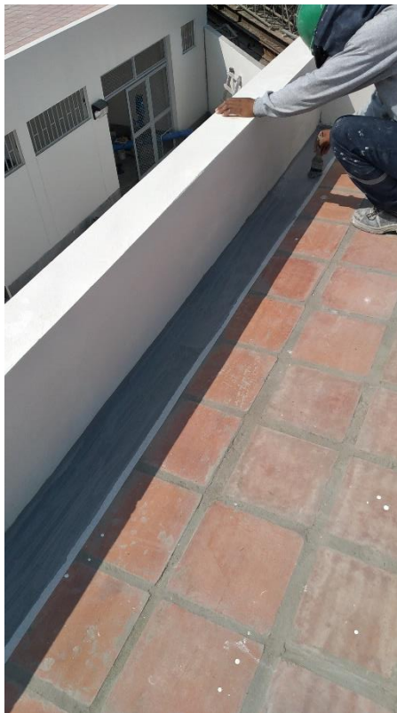
20.0 Pintado de canaletas en techos
