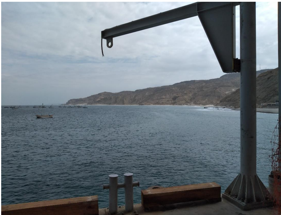
21.0 Ya se tiene instalado al 100% las bitas y el sardinell de madera
