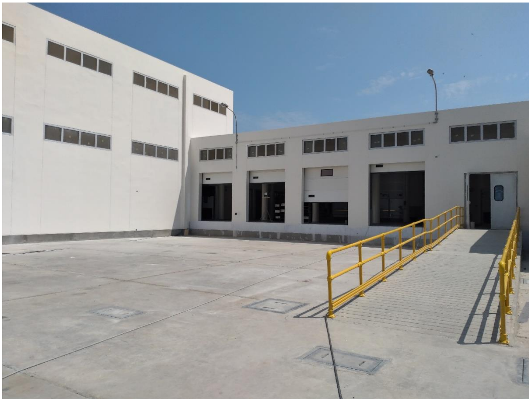
14.0 Se instaló las barandas de fibra de vidrio en su totalidad al 100%
