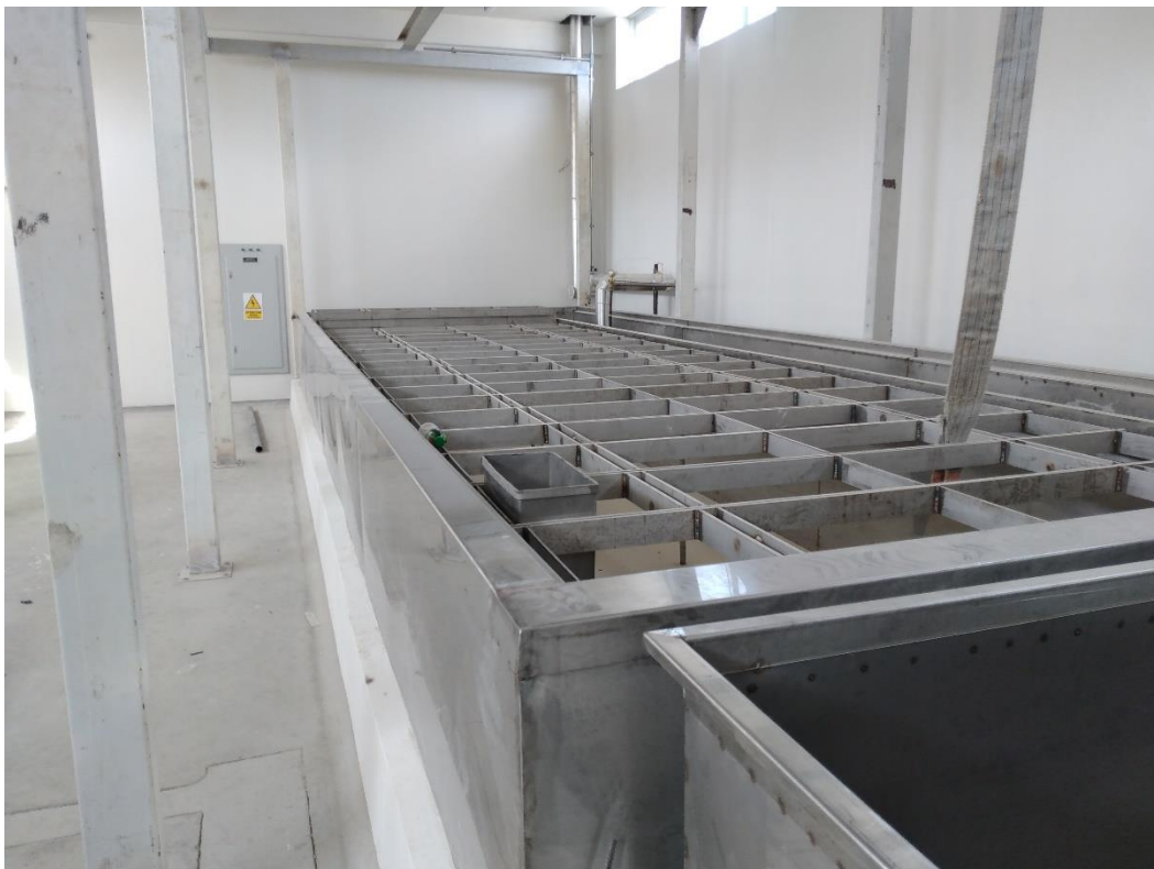
16.0 Instalacion de estructura para cubetas de acero en productor de hielo
