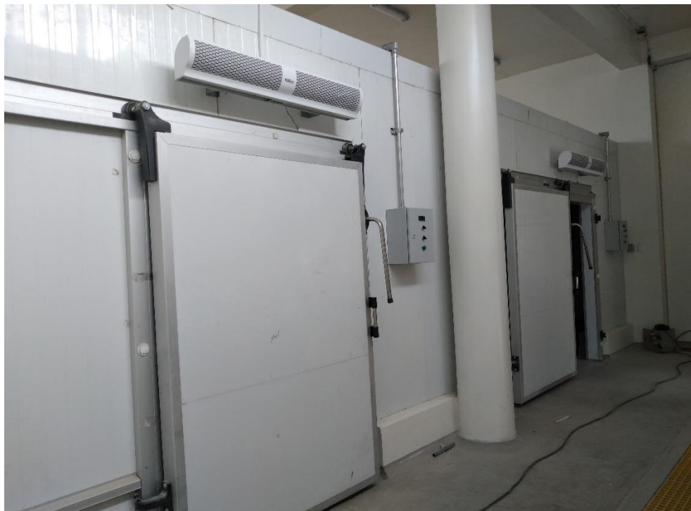
10.0 Se culminó el montaje de las cámaras de frío de 5 y 10 tn, Ya se realizaron las pruebas correspondientes
