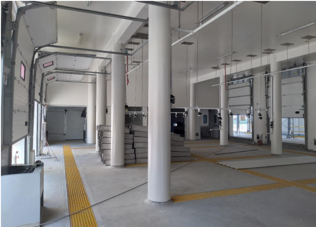
13.0 Se realizó el montaje de las rejillas de fibra de vidrio en tareas previas ,área de frios -culminado al 100%
