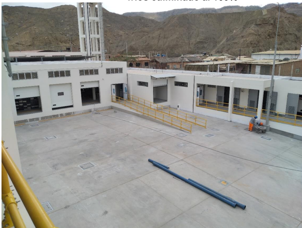
8.0 Se esta finalizando con el sellado de juntas del patio de maniobras, ya se tiene pintado al 100% los muros con epoxico colo blanco y se está realizando el pintado de los contrazocalos
