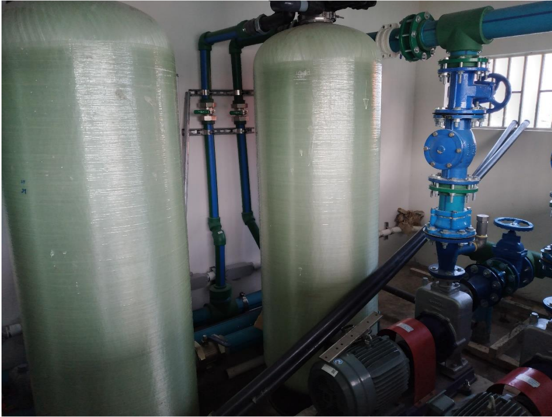
17.0 Instalacion de planta de pre tratamiento caseta de captacion
