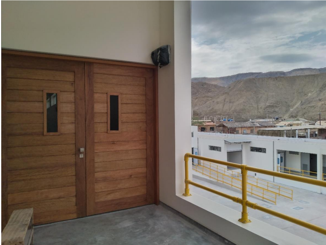
7.0 Se instaló las puertas de madera doble hoja en segundo piso de área de frios culminado al 100%
