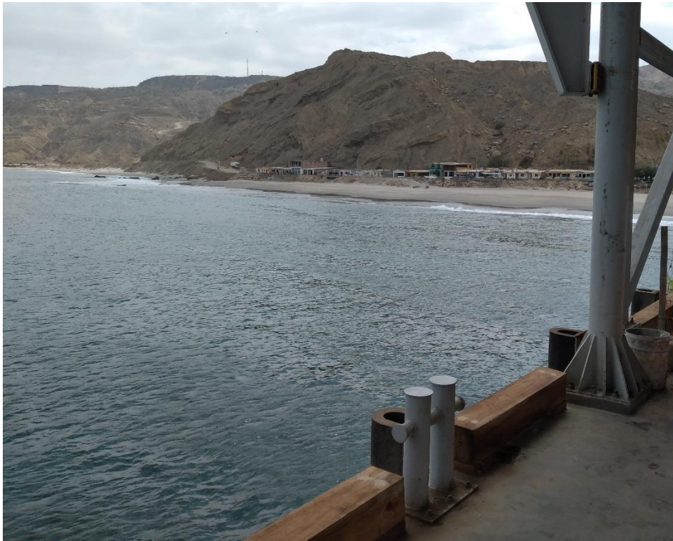
21.0 Ya se tiene instalado al 100% las bitas y el sardinell de madera
