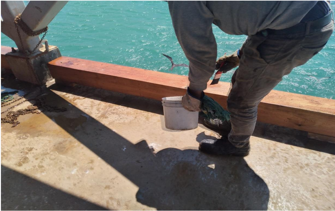
19.0 Se esta realizando el pintado con preservante de madera
