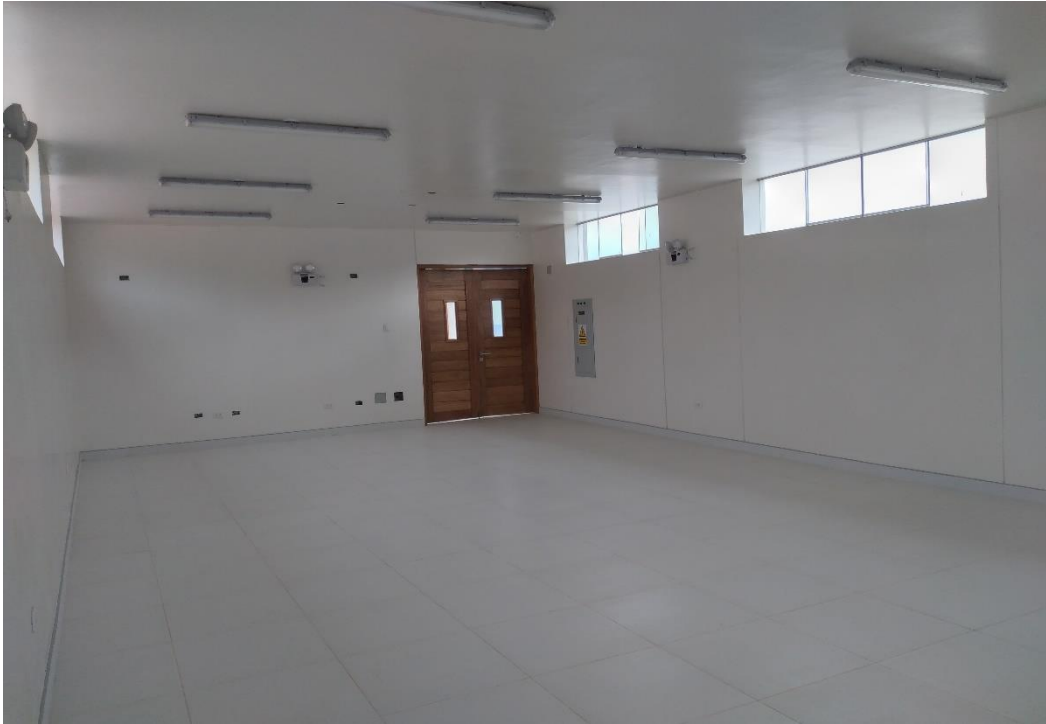
3.0 Se culminó con la instalación de puertas de madera y pintado interior de área de auditorio culminado al 100%
