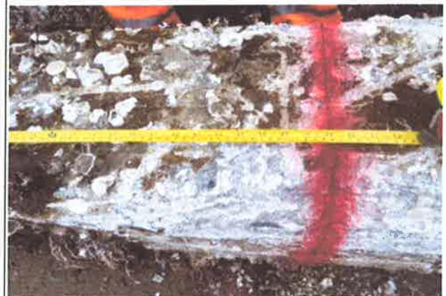
Medición de profundidad de corte del pilote (1.3 m)
