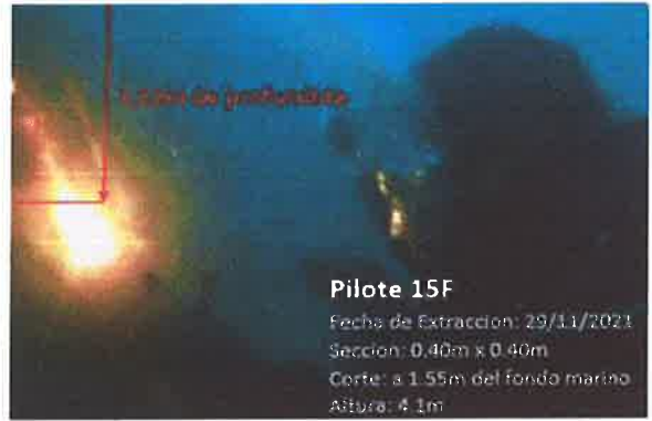
Fractura y corte del pilote (15 F) a 1.55 m debajo del fondo marino (arenoso)
