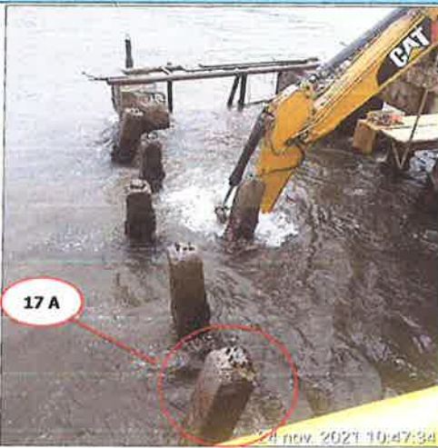
Foto panoramica de los pilotes del cabezo , limpieza y excavacion.
