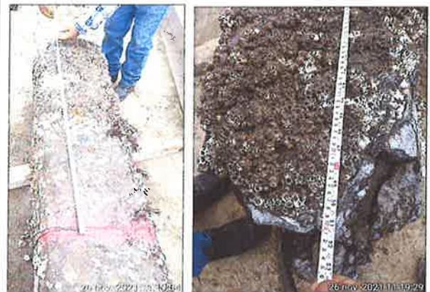
Medicion de profundidad de corte del pilote ( 1.3 m )
