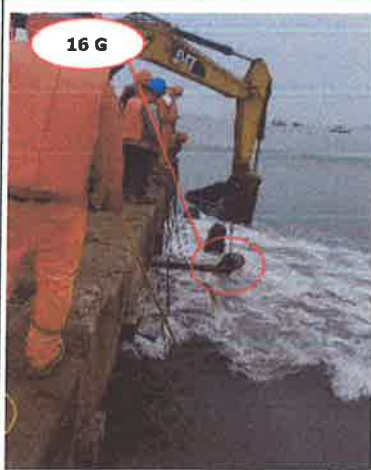
Foto panoramica de los pilotes del cabezo , limpieza y excavación.
