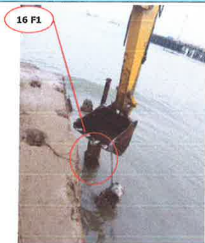
Foto panorámica de los pilotes del cabezo, limpieza y excavación.
