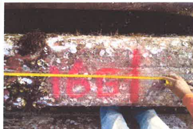
Medición de profundidad de corte del pilote (1.44 m)
