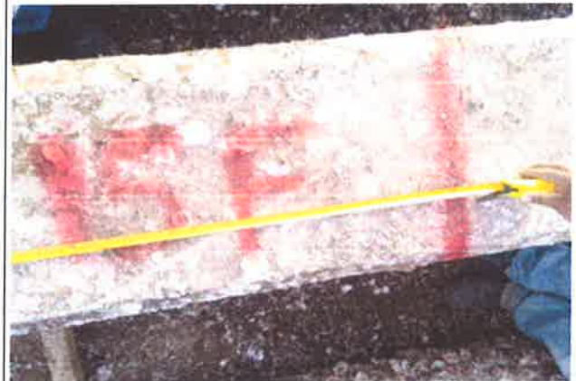
Medición de profundidad de corte del pilote ( 1.55 m )
