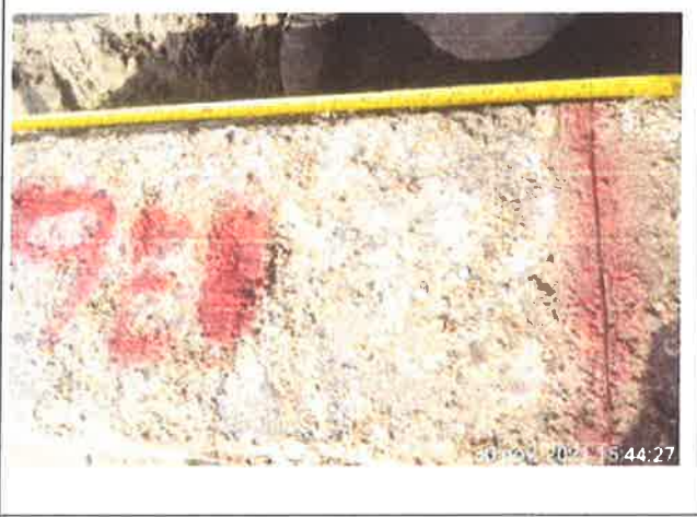
Medición de profundidad de corte del pilote ( 1.25 m )
