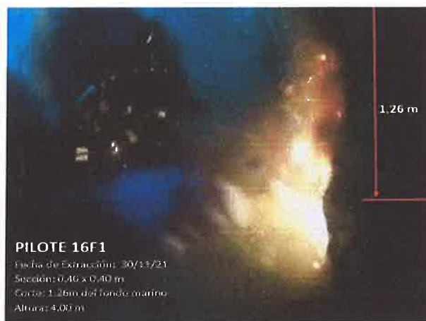
Fractura y corte del pilote (16 F1) a 1.26 m debajo del fondo marino (arenoso)
