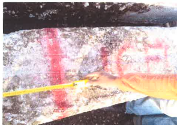
Medición de profundidad de corte del pilote ( 1.26 m )
