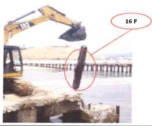
Foto panoramica de los pilotes del cabezo , limpieza y excavación.
