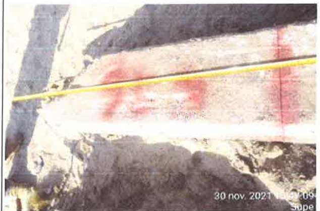
Medicion de profundidad de corte del pilote ( 1.15 m )
