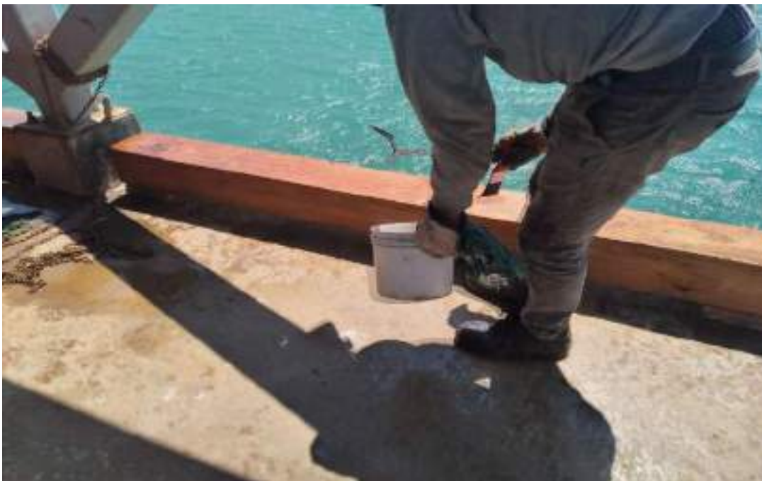
8.0 Se esta realizando el pintado con peservante de madera
