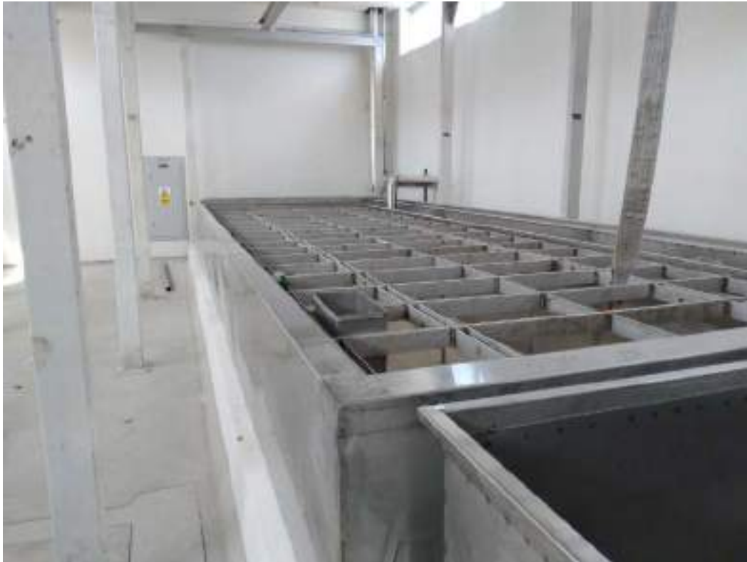
5.0 Instalacion de estructura para cubetas de acero en productor de hielo
