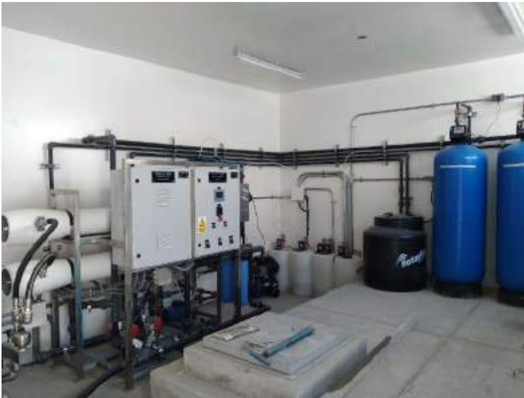
1.0 Se realizó el montaje de la planta de Osmosis-culminado al 100%
