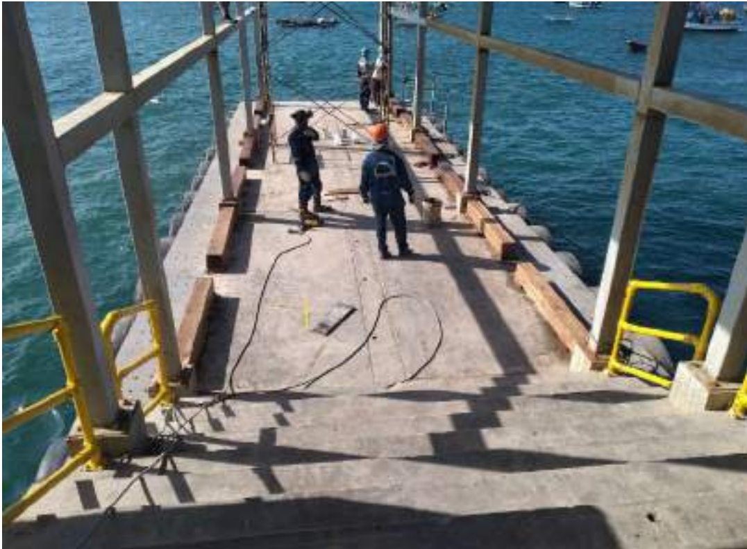
7.0 Instalacion de sardinel de madera en plataforma baja y alta
