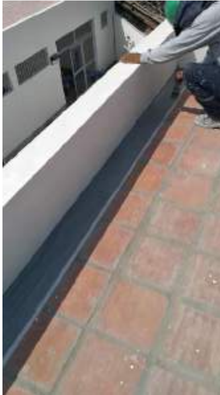
9.0 Pintado de canaletas en techos
