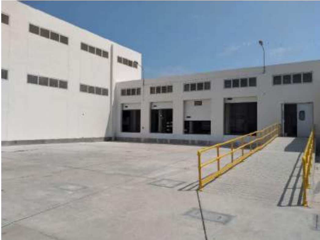
3.0 Se instalo las barandas de fibra de vidrio en su totalidad al 100%
