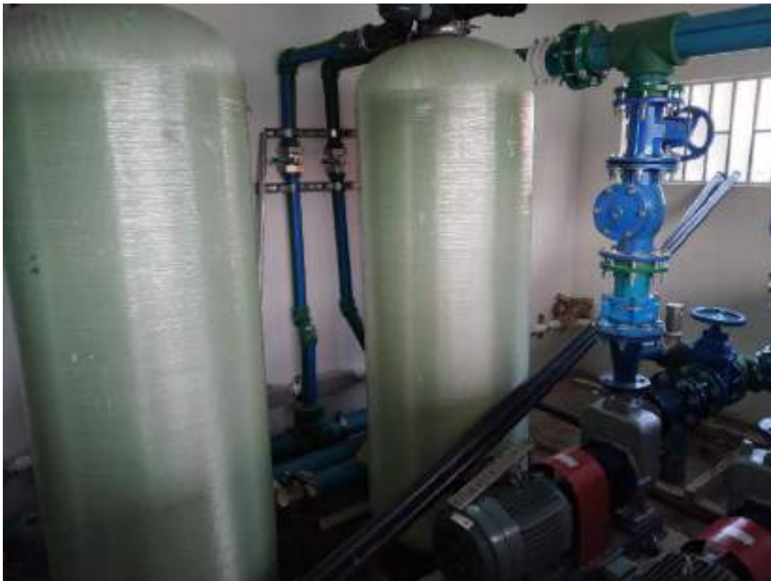
6.0 Instalacion de planta de pre tratamiento caseta de captacion
