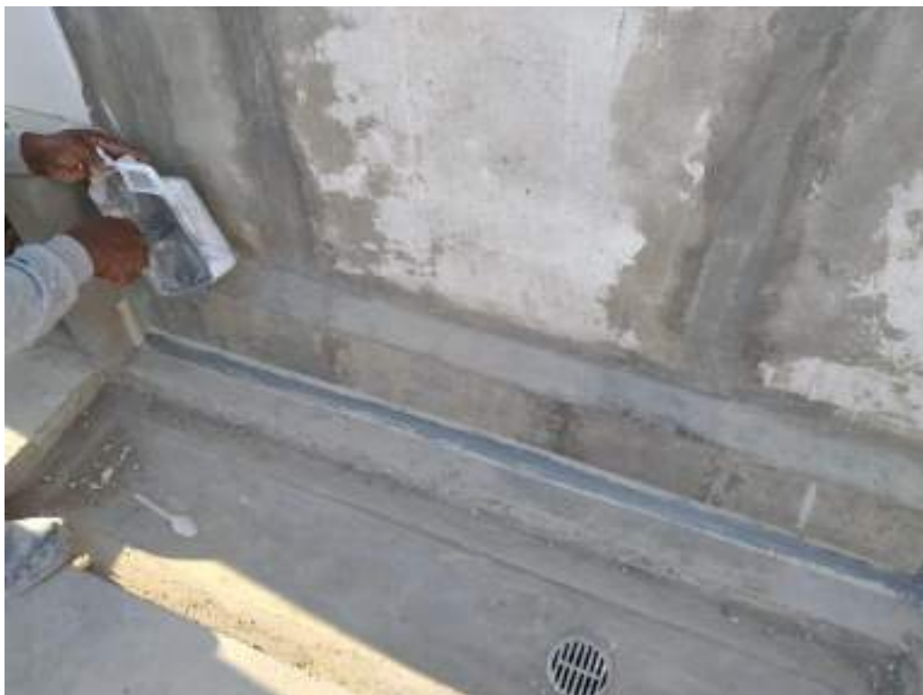
8.0 Se está ejecutando la instalación de sello elastomérico en pisos
