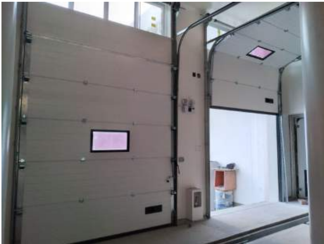
4.0 Se realizó la instalación de las puertas seccionables en el área de tareas previas
