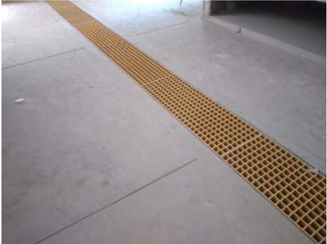
3.0 Se está ejecutando la instalación e rejillas de fibra de vidrio
