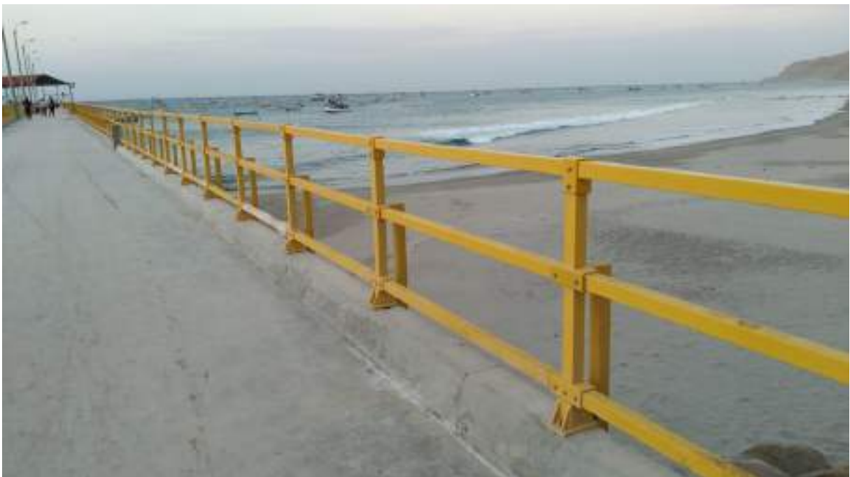
10.0 Se está ejecutando la instalación de barandas de fibra de vidrio
