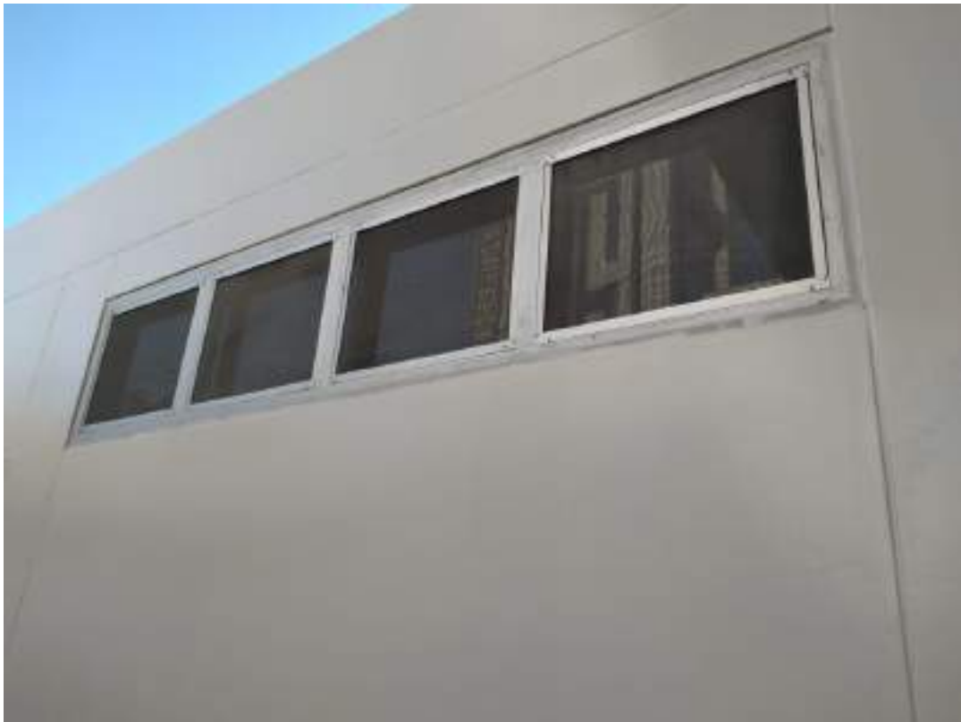
5.0 ya se culminó la instalación de las ventanas con malla mosquitero
