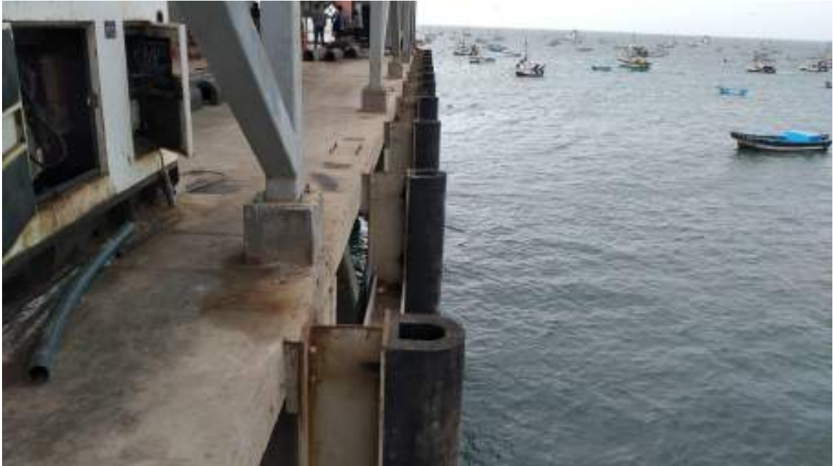
1.0 Se realizó el montaje de instalación de la defensa tipo D en el muelle plataforma alta -culminado al 100%
