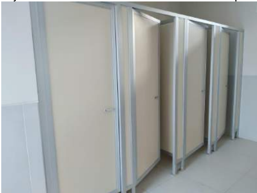
6.0 ya se culmino la instalación de divisiones de melamine en servicios higienicos
