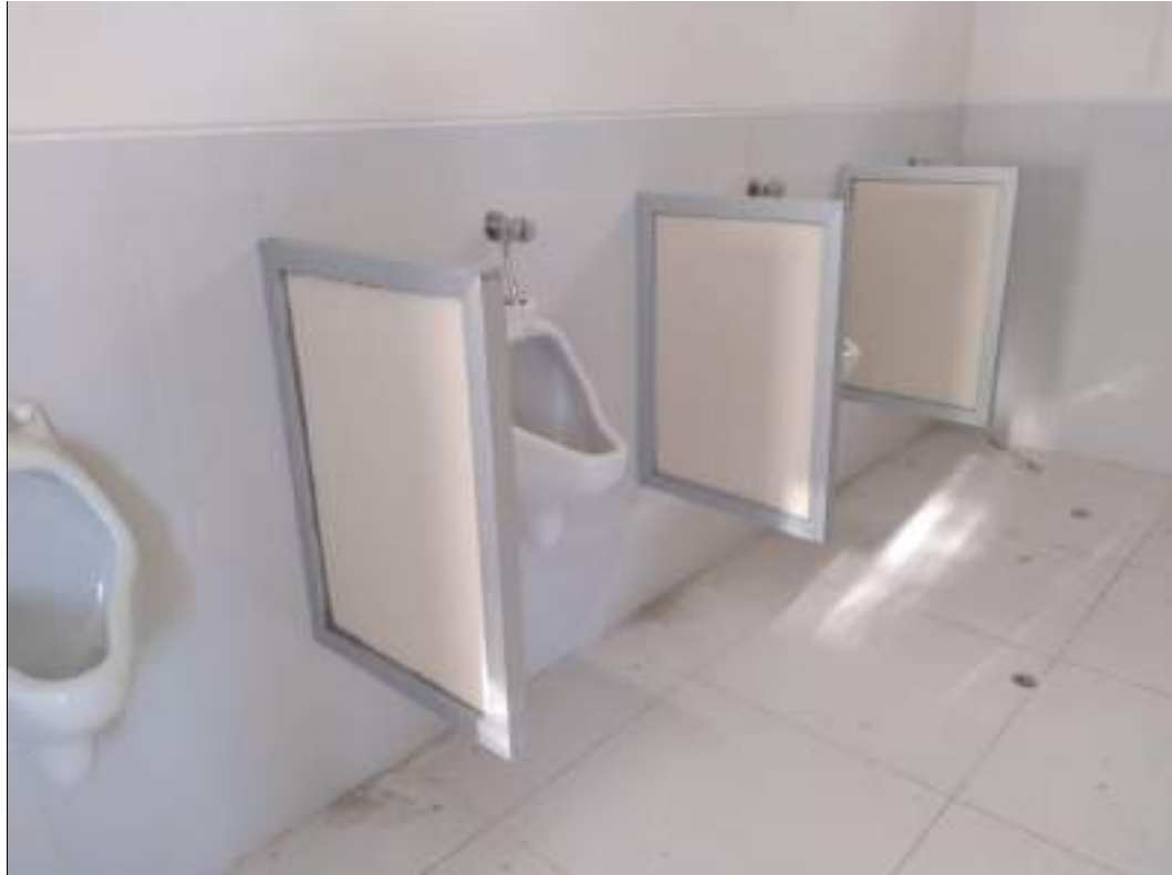
7.0 Se culminó la instalación de división de urinarios en servicios higiénicos
