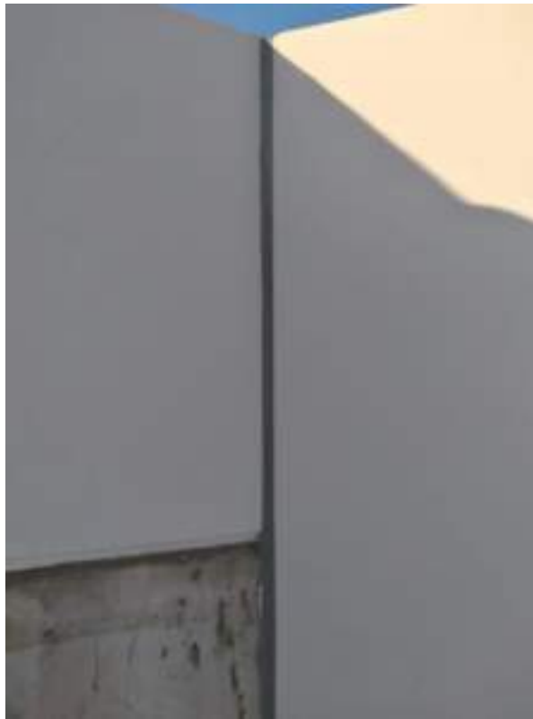
9.0 Se está ejecutando la instalación sellado de juntas verticales
