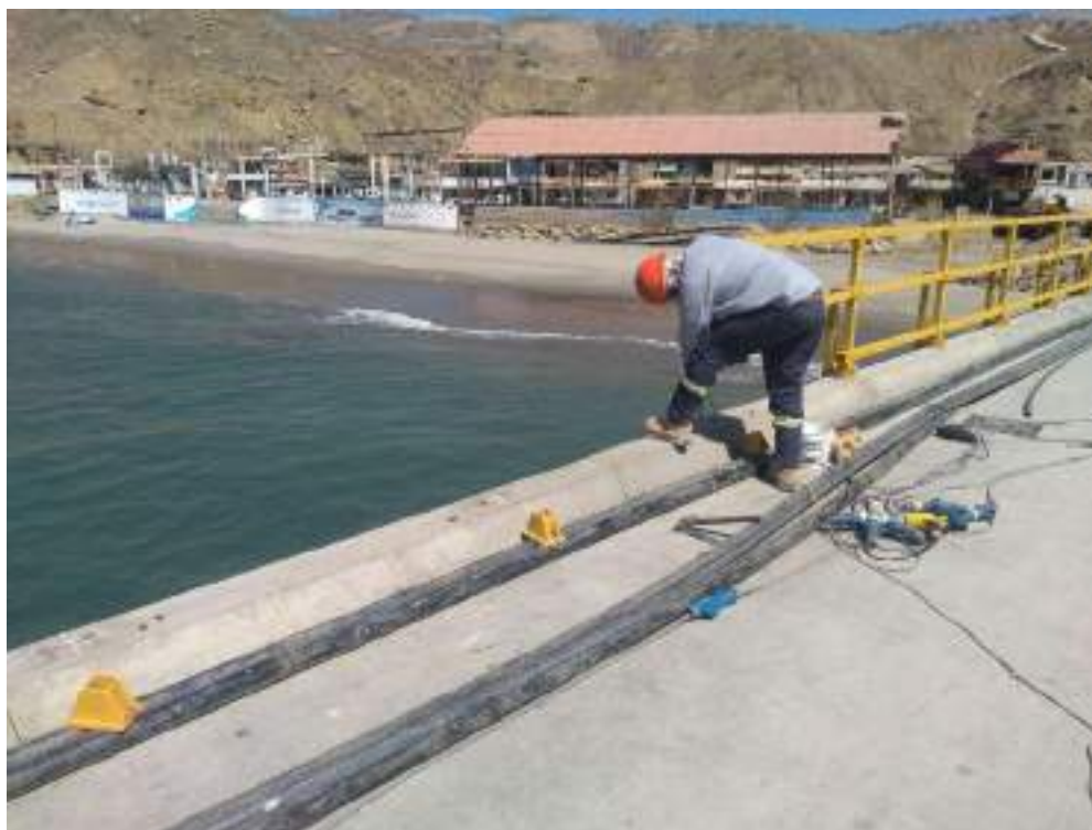
FOTO N° 04: DESMONTAJE Y ANCLAJE DE BARANDA
