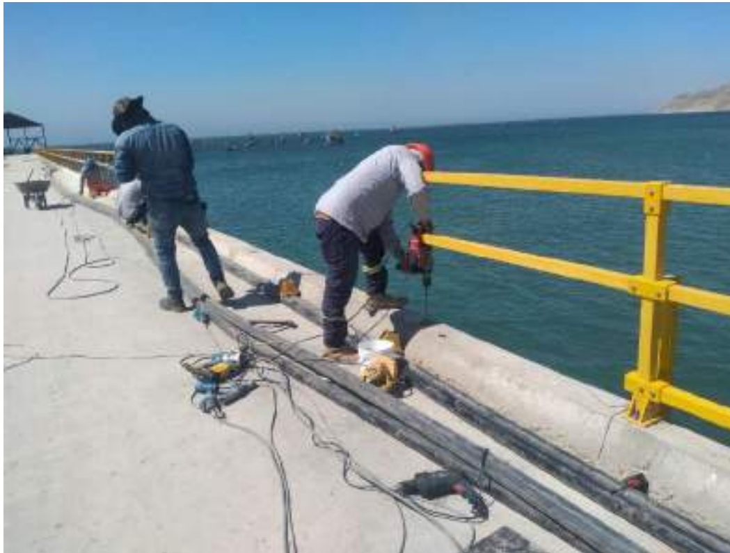
FOTO N° 05: PERFORACION PARA ANCLAJES DE BASES DE BARANDA
