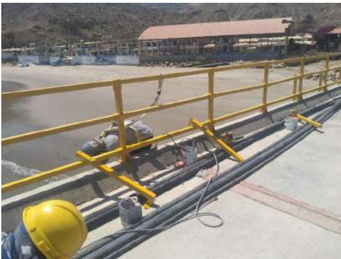
FOTO N° 02: PERFORACION DE AGUJEROS PARA ANCLAJES DE REFUERZOS
