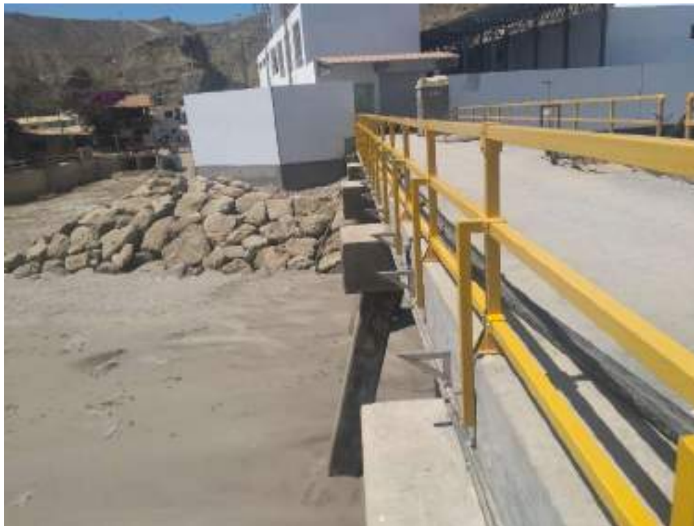
FOTO N° 03: 50 ML DE REFUEROS Y BARANDAS REINSTALADAS
