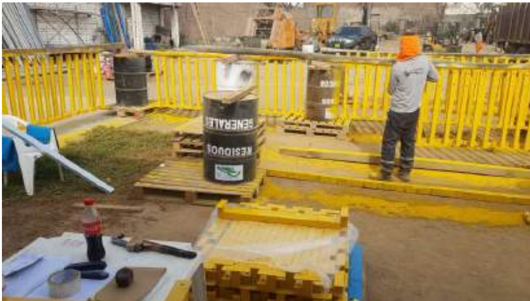
FOTO N° 01: FABRICACION Y PINTADO DE REFUERZOS CON PINTURA EPOXICA
