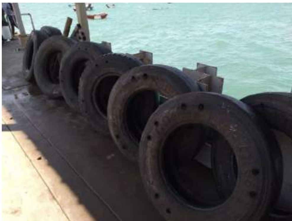
FOTO N° 02: PERFORACION DE AGUJEROS PARA COLOCACION DE LLANTAS
