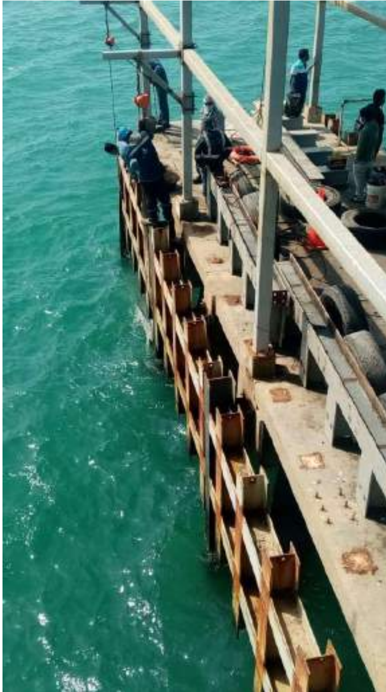
FOTO N° 03: IZAJE DE ESTRUCTURA PARA TERCERA FILA
