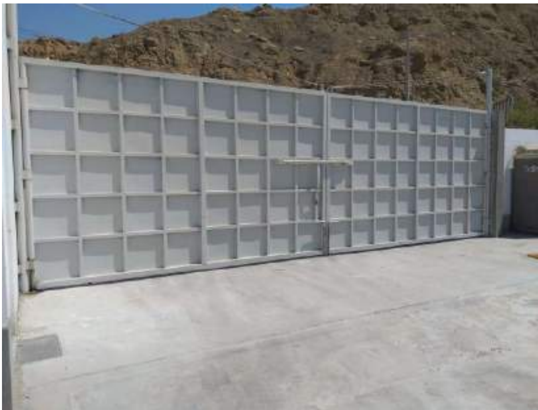
FOTO N° 05: FABRICACION Y MONTAJE DE PUERTA PRINCIPAL
