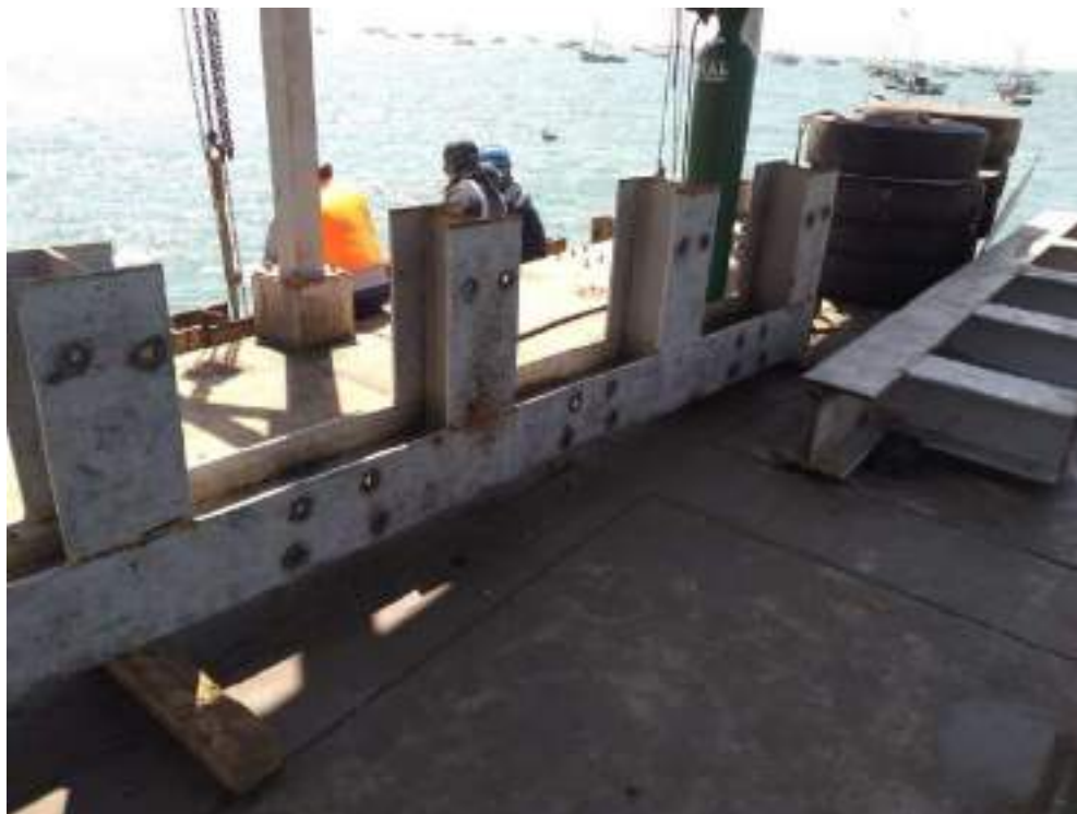
FOTO N° 01: FABRICACION DE ESTRUCTURA PARA LA TERCERA FILA
