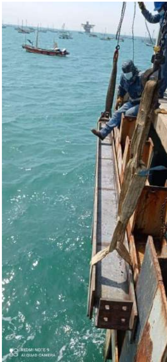
FOTO N° 04: IZAJE DE ESTRUCTURA
