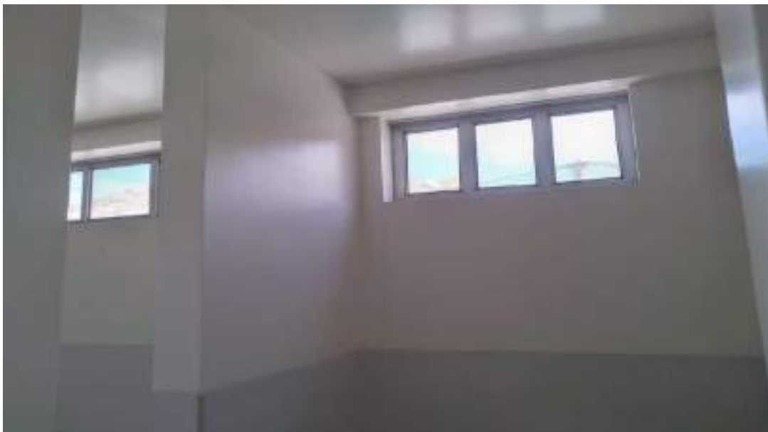
4.0 Se realizó la instalación de los protectores con malla mosquitera en el área de desinfección al 100%
