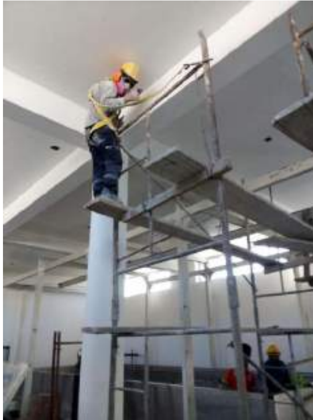
15.0 Trabajos de pintura en área de frios
