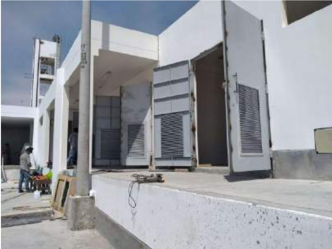
3.0 Ya se ejecuta la fabricación y montaje de las puertas del área de tableros, sub estación y grupo electrógeno se tiene un avance del 95% está pendiente el cavado de pintura final
