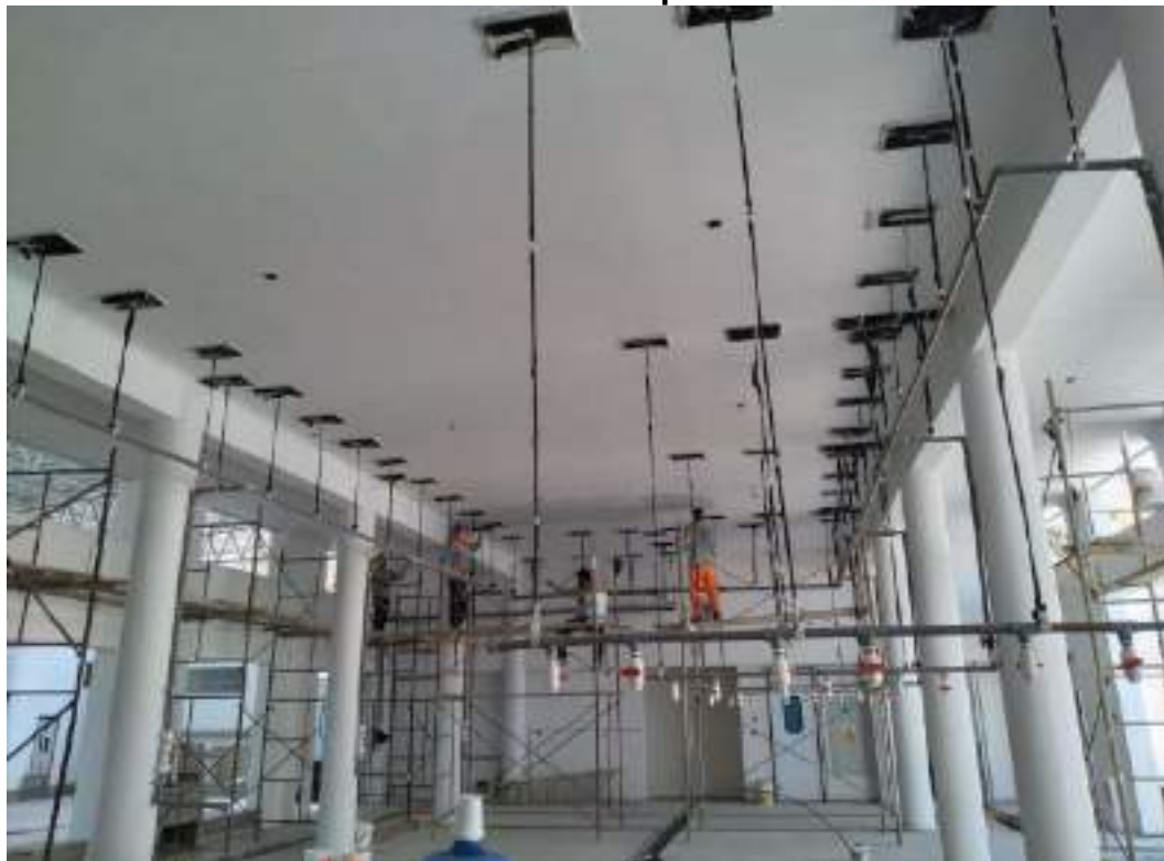
10.0 Se está ejecutando el pintado del ambiente con epóxido de tareas previas
