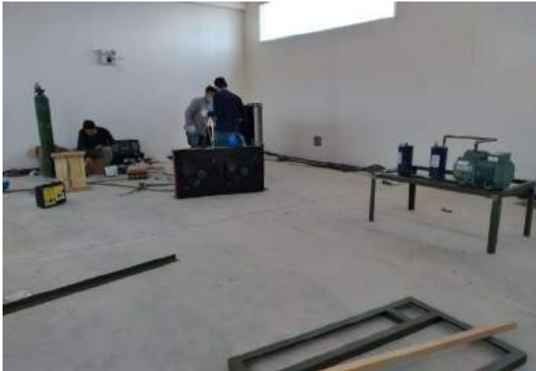
7.0 Se esta ejecutando la instalación de motores en el segundo piso para el funcionamiento de las cámaras de frío
