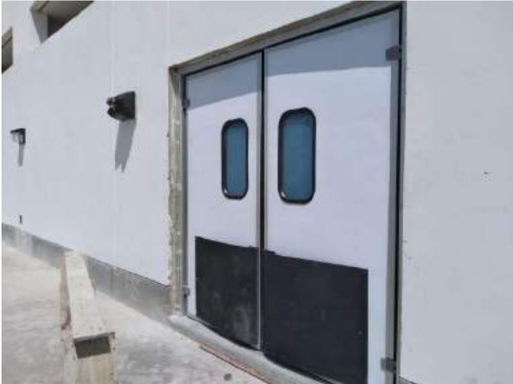
1.0 Se realizó el montaje de instalación de puertas de alto impacto en área de deposito de carretas culminado al 100%
