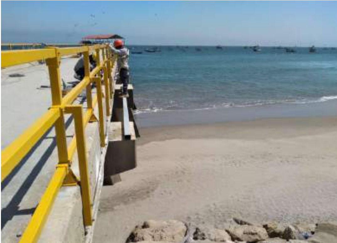
9.0 Se está ejecutando la instalación de barandas de fibra de vidrio con su refuerzo correspondiente
