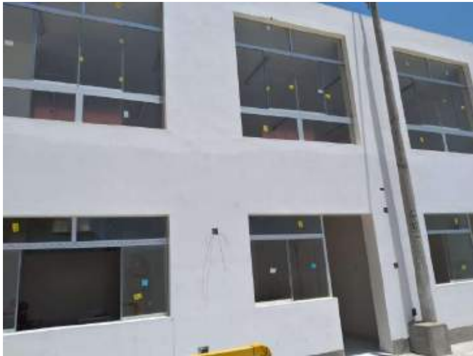
13.0 Se sigue instalando las ventanas de vidrio templado en las distintas áreas
