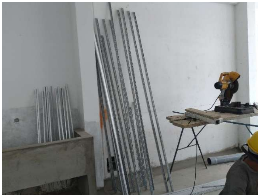
10.0 Se viene ejecutando la habilitación de los aluminios para la instalación de ventanas.
