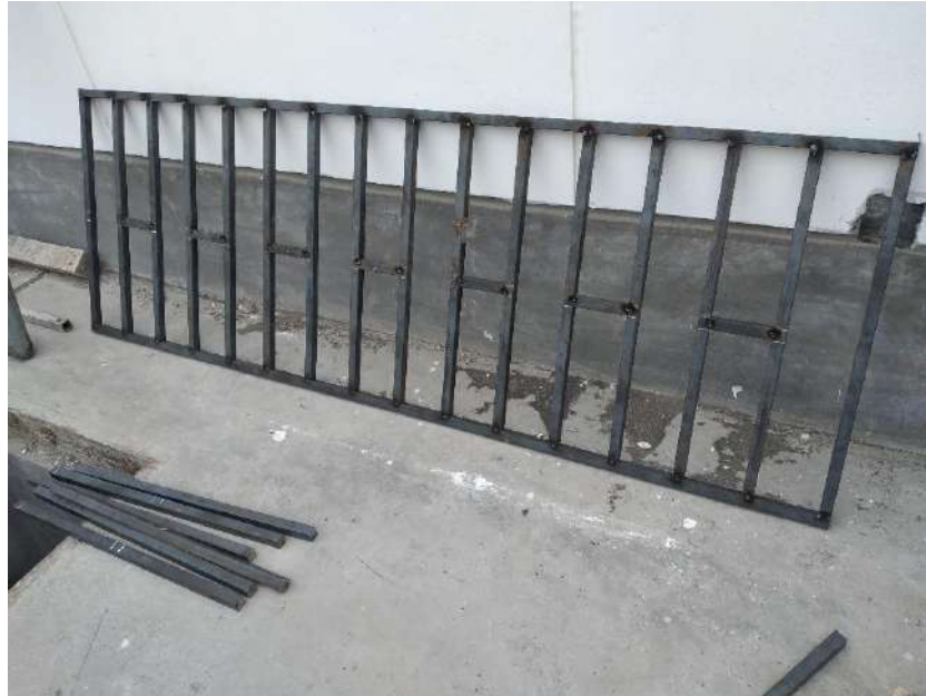
9.0 Se está ejecutando la fabricación de las ventanas tipo rejas para el área de talleres.
