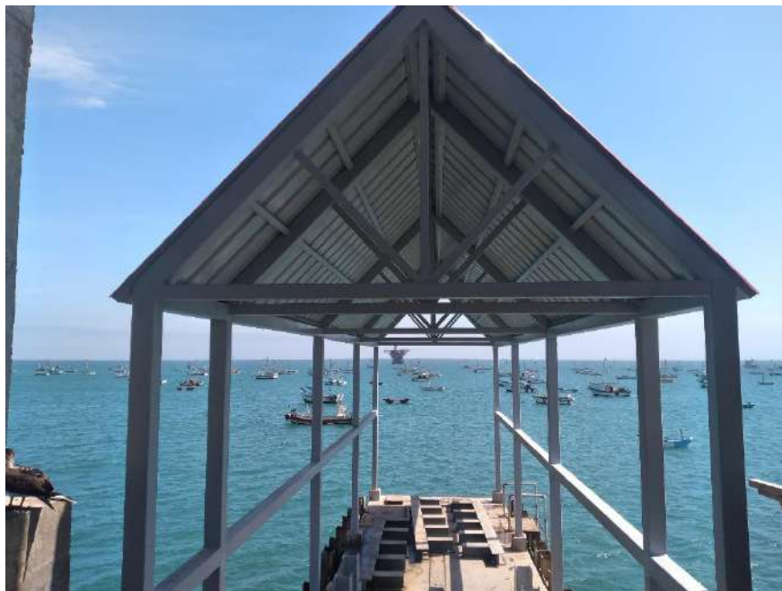
2.0 Se realizó el montaje de estructura, cobertura y el pintado en techo de cabezo culminado al 100%
