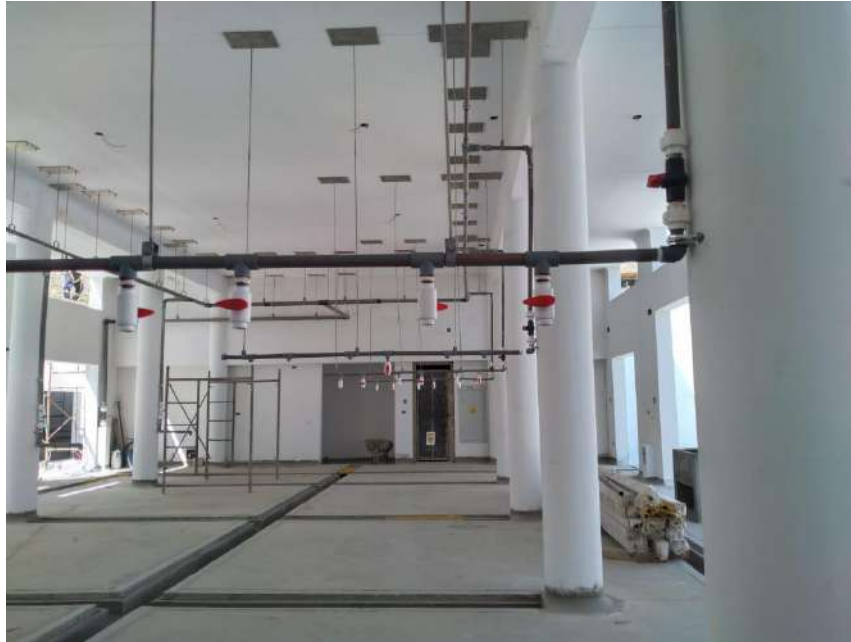
7.0 Se tiene ejecutado el montaje de las instalaciones sanitarias colgantes en el área de tareas previas.
