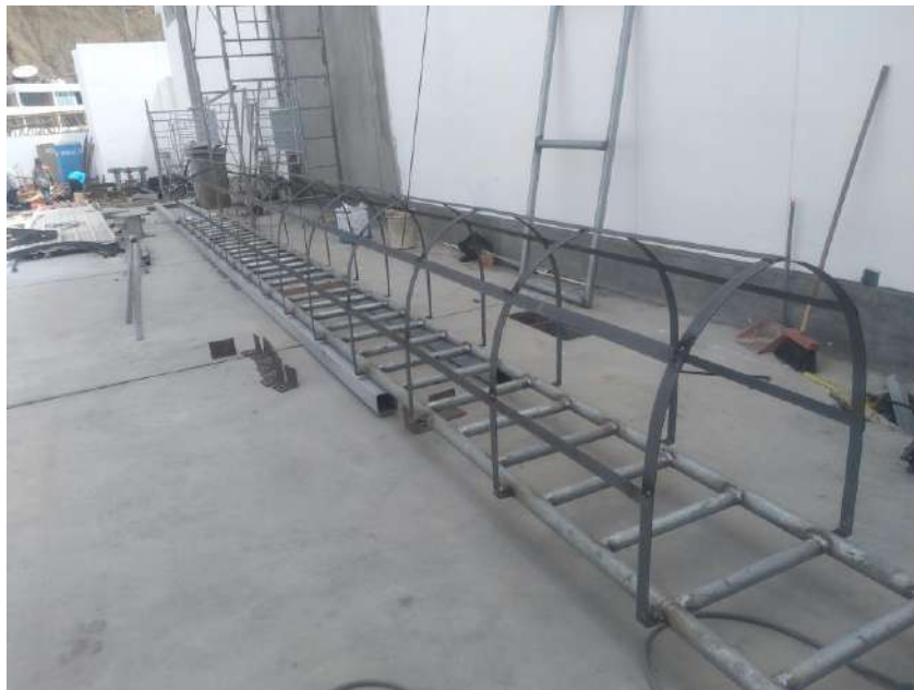
8.0 Se está ejecutando la escalera de gato de 22.00 mt de largo para el tanque elevado
