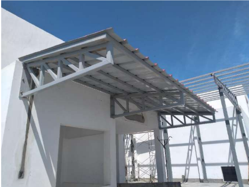
3.0 Se realizó el montaje de estructura, cobertura y el pintado en techo de pesaje área de sociales culminado al 100%
