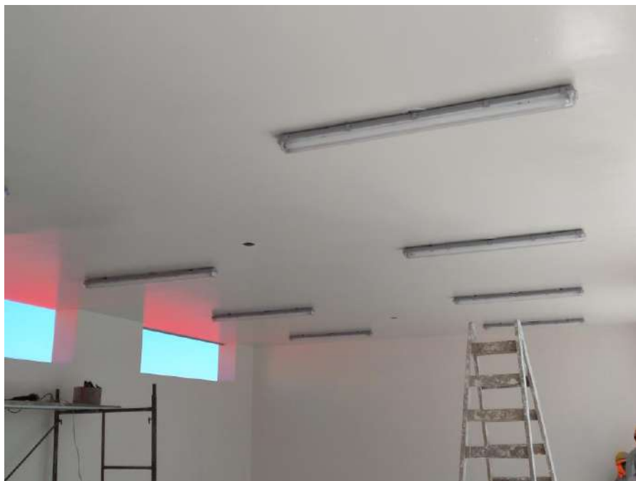
12.0 Se está ejecutando la instalación de luminarias en el área de sociales
