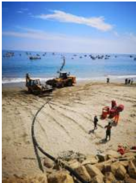
Fotografía 5. Lanzamiento y hundimiento de la tubería HDPE 6"
