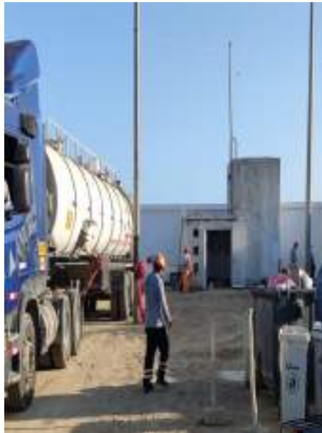
Fotografía 11. Extracción y eliminación de material sedimentado con equipo hidroject.
