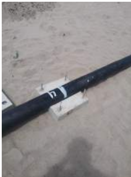
Fotografía 4. Habilitación y colocación de lastres de concreto en tubería HDPE 6"
