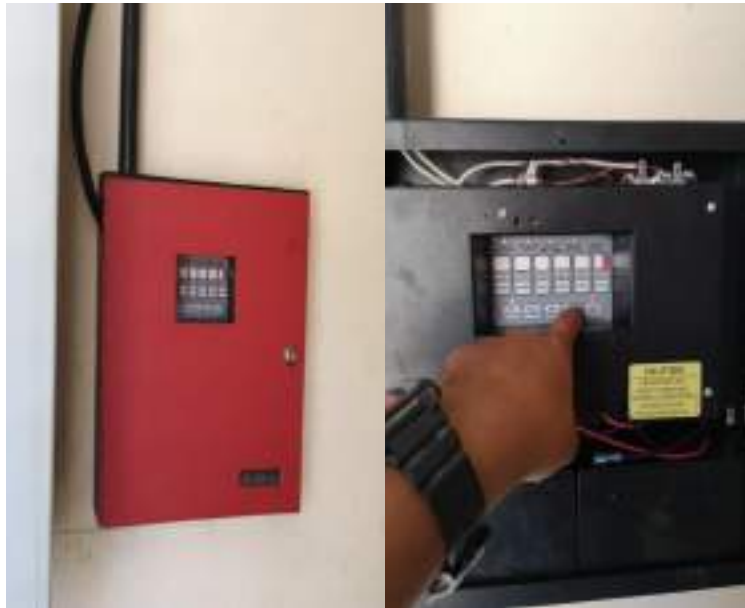
Fotografía 9. Colocación de panel contraincendio 4 zonas, sensor contraincendio y sirena.
