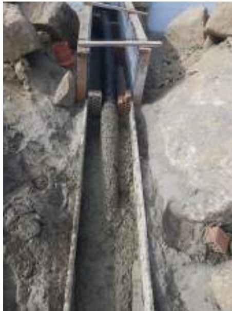
Fotografía 13. Vaciado de dado de concreto para recubrimiento de la tubería HDPE 6"
