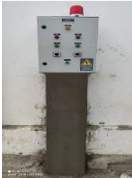
Fotografía 1. Construcción de podios de concreto para los tableros eléctricos.
