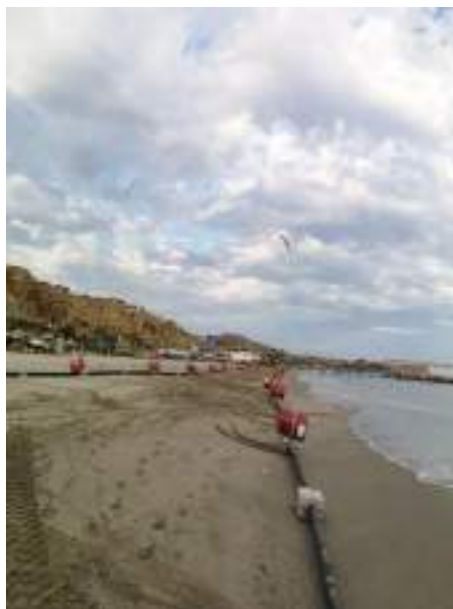
Fotografía 6. Lanzamiento y hundimiento de la tubería HDPE 6" y colocación de los cilindros para la flotabilidad de la tubería HDPE 6".
