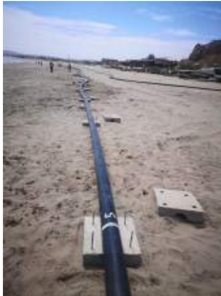
Fotografía 3. Habilitación y colocación de lastres de concreto en tubería HDPE 6"
