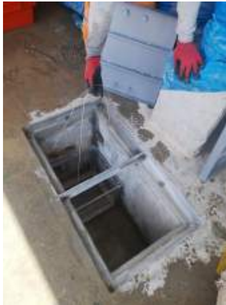
Fotografía 7. Colocación y habilitación de la canastilla de acero inoxidable y cables metálicos para facilitar.
