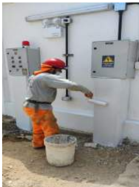
Fotografía 2. Pintado de podios de concreto para tableros eléctricos.
