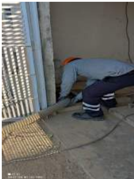
Fotografía 12. Extracción y eliminación de material sedimentado con equipo hidroject
