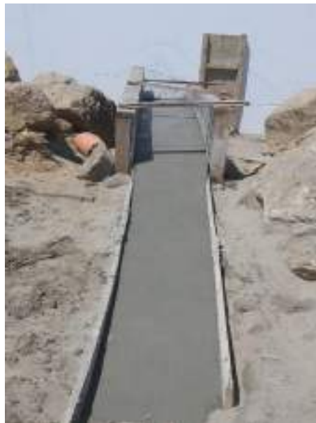
Fotografía 14. Dado de concreto para recubrimiento de la tubería HDPE 6"
