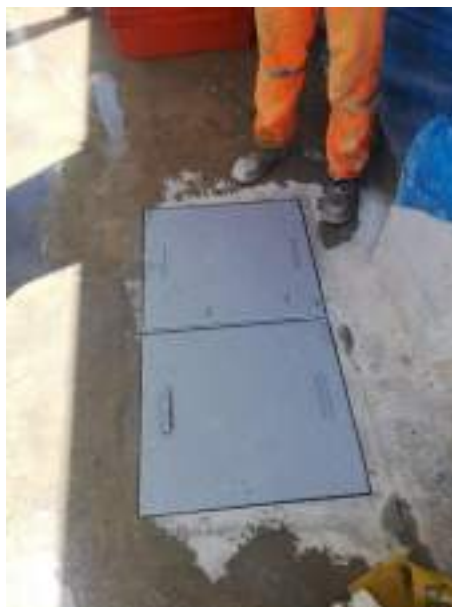
Fotografía 8. Colocación y habilitación del ángulo para tapas metálicas estriadas.
