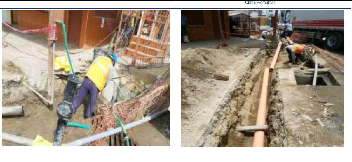
Foto 11 y 12: Tendido de las tubería PVC de desagüe hacia el colector publico
