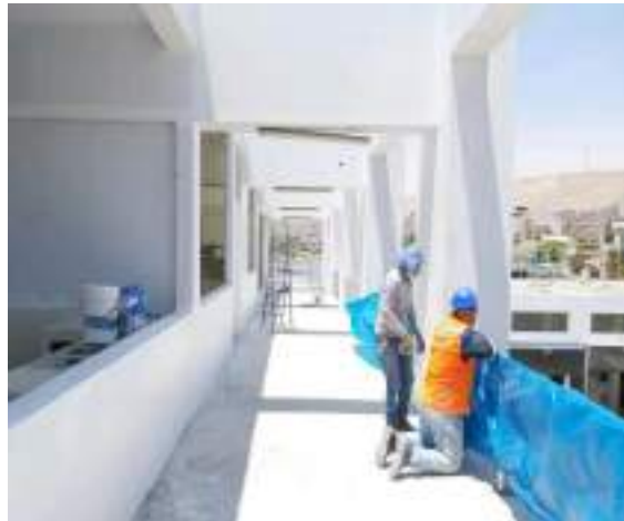
Foto 36 y 37: Pintado interior y exterior con epóxico del bloque de fríos
