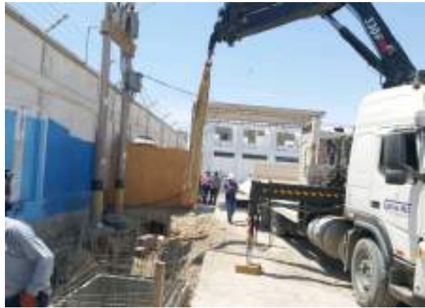
Foto 34 y 35: Colocación de la cámara de bombeo de concreto prefabricado en su ubicación final
