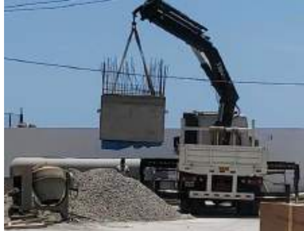
Foto 32 y 33: Izaje de la cámara de bombeo de concreto prefabricado para su colocación final
