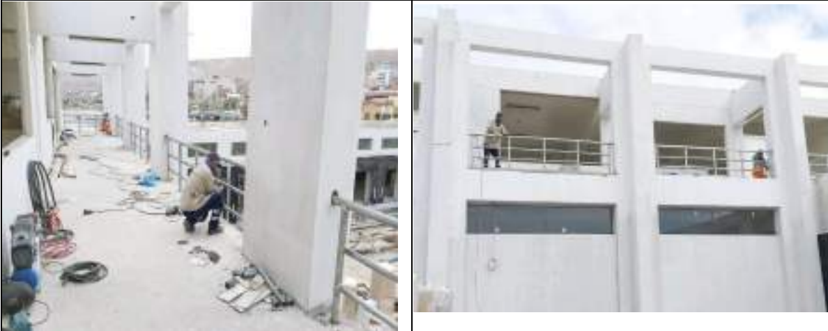
Foto 03 y 04: Suministro y colocación de las barandas de fierro galvanizado ubicados en el segundo piso bloque de frios
