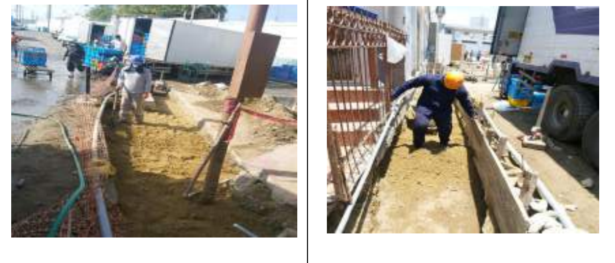
Foto 13 y 14: Relleno con material de préstamo para la base de la veredas en el ingreso al DPAI
