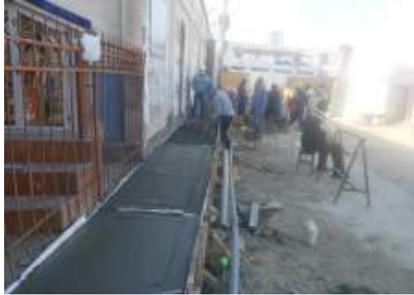
Foto 23 y 24: Ejecución de las partidas de la base y colocación de concreto para las veredas
