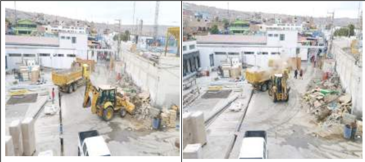
Foto 01 y 02: Eliminación de material excedente ubicado en el patio de maniobras
