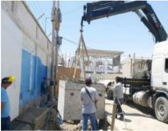
Foto 34 y 35: Colocación de la cámara de bombeo de concreto prefabricado en su ubicación final
