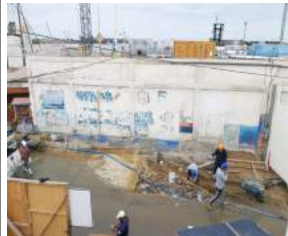
Foto 21 y 22: Curado de reposición de la losa de concreto en el ingreso al DPAI
