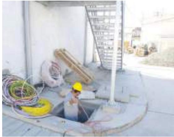
Foto 29 y 30: Cableado de los alimentadores de la red de baja tensión
