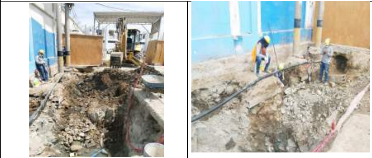
Foto 08 y 09: Excavación en terreno rocoso para la colocación de la cámara de bombeo N° 06, pozos de tierra y buzón eléctrico para el sistema de media tensión, ubicados en el ingreso al DPAI
