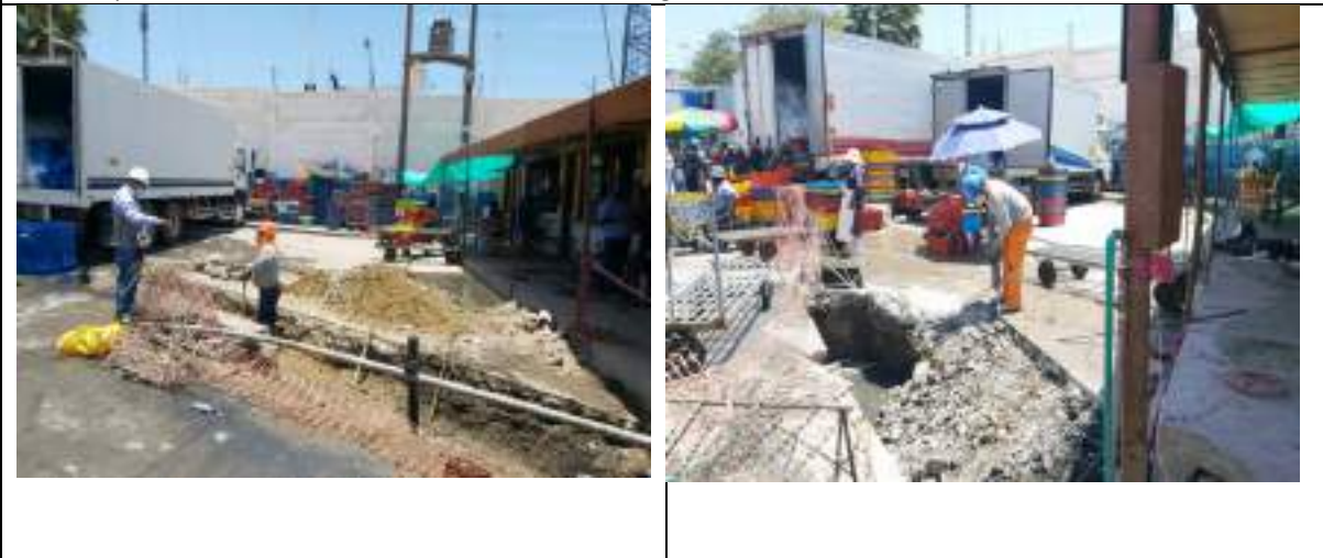
Foto 10 y 11: Demolición de losa y excavación de zanja para el tendido del desagüe al colector público
