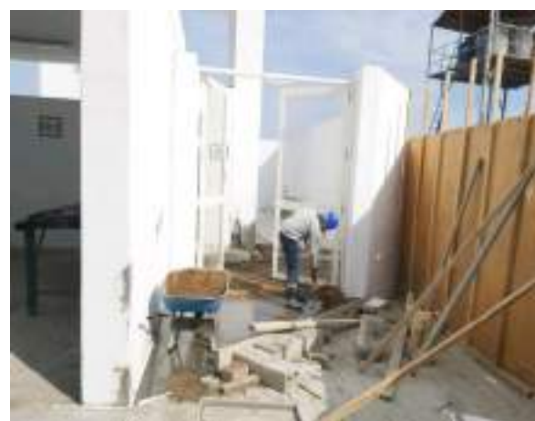
Foto 25 y 26: Excavación de terreno rocosa para la construcción del pozo de tierra de media tensión en el ingreso al DPAI
