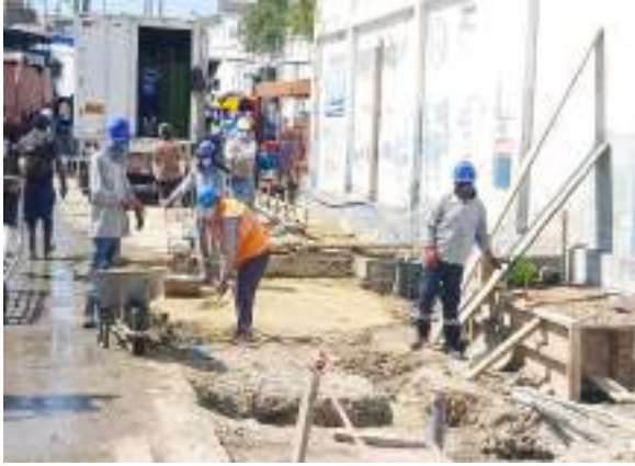
Foto 17 y 18: Reposición de la losa de concreto en el ingreso al DPAI
