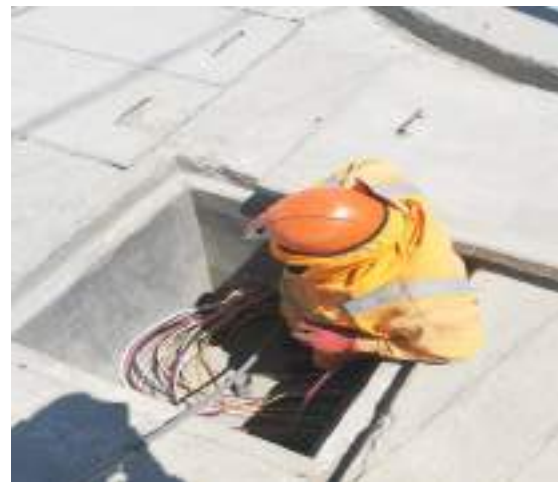
Foto 29 y 30: Cableado de los alimentadores de la red de baja tensión
