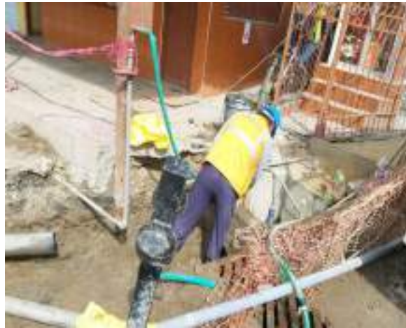
Foto 11 y 12: Tendido de las tubería PVC de desagüe hacia el colector publico
