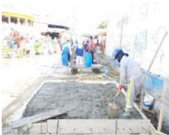
Foto 17 y 18: Reposición de la losa de concreto en el ingreso al DPAI
