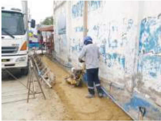
Foto 23 y 24: Ejecución de las partidas de la base y colocación de concreto para las veredas
