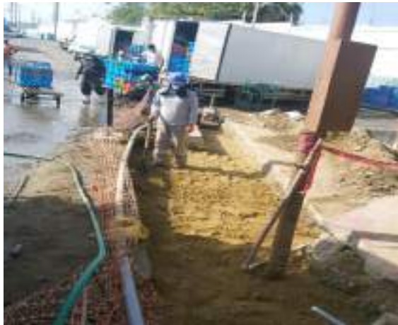
Foto 11 y 12: Tendido de las tubería PVC de desagüe hacia el colector publico
