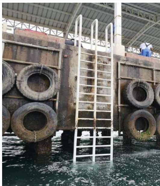
FOTO N° 06 – COLOCACION DE ESCALERAS TIPO GATO METALICAS
