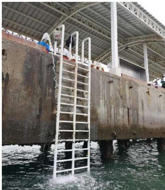
FOTO N° 04 – COLOCACION DE ESCALERAS TIPO GATO METALICAS
