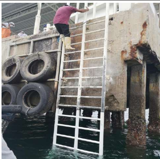
FOTO N° 03 – COLOCACION DE ESCALERAS TIPO GATO METALICAS
