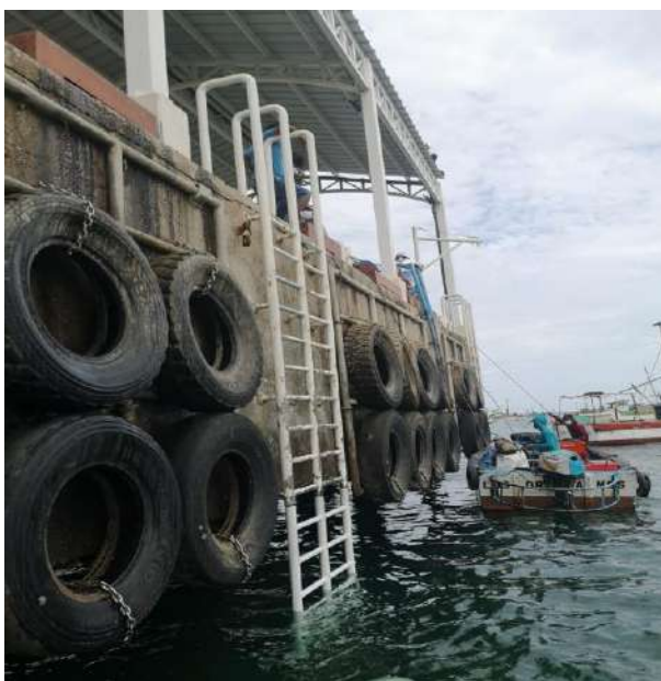
FOTO N° 05 – COLOCACION DE ESCALERAS TIPO GATO METALICAS
