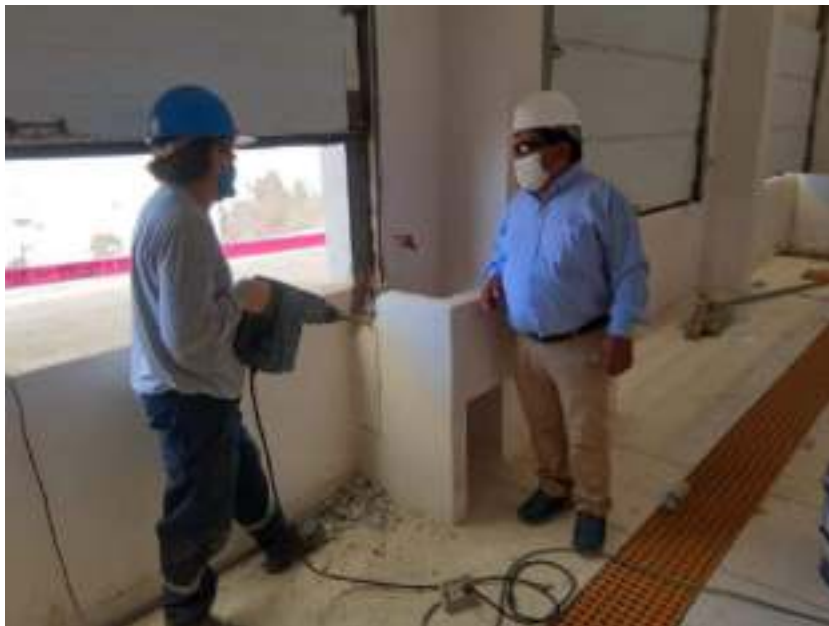
FOTO 04: DEMOLICION DE LAVADERO
