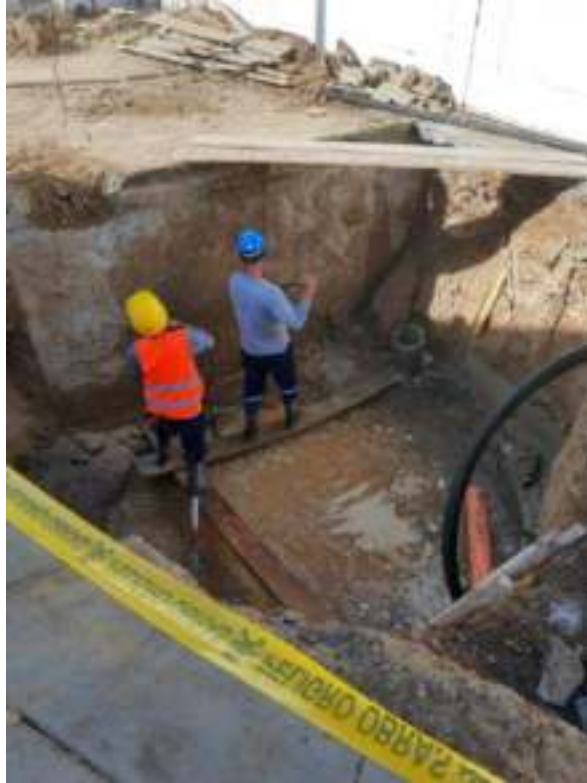
FOTO 04: REFINE Y NIVELACION DE CUARTO DE BOMBAS
