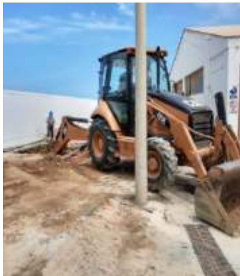
FOTOGRAFIA N° 02: Excavación con maquinaria para cuarto de bombas
