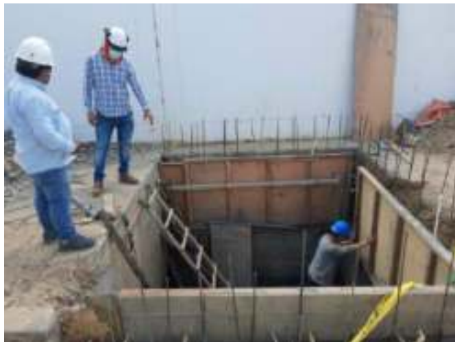
FOTOGRAFIA N° 04: Vaciado de concreto 350 kg/cm 2 para muros
