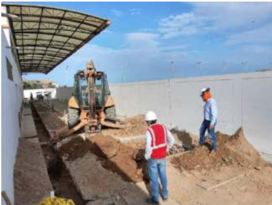
FOTO 03: EXCAVACION DE TRAMPA DE GRASA
