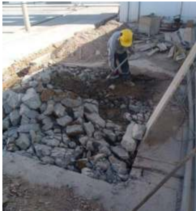
FOTO 02: DEMOLICION DE LOSA PARA CUARTO DE BOMBAS
