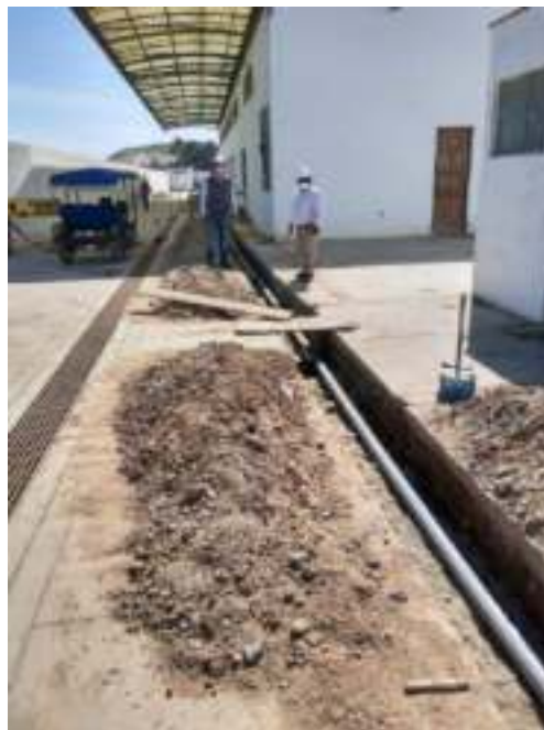
FOTOGRAFIA N° 10 tendido de tubería Pvc 2" ½ agua potable y Tubería Pvc 3" agua salada
