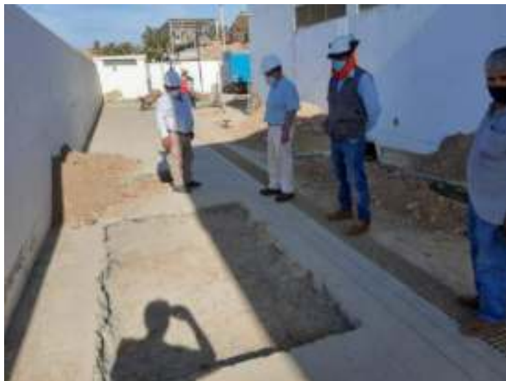
FOTOGRAFIA N° 06 Excavación manual de trampa de grasa
