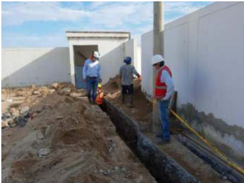
FOTO 05: DEMOLICION DE LOSA Y EXCAVACION DE ZANJA
