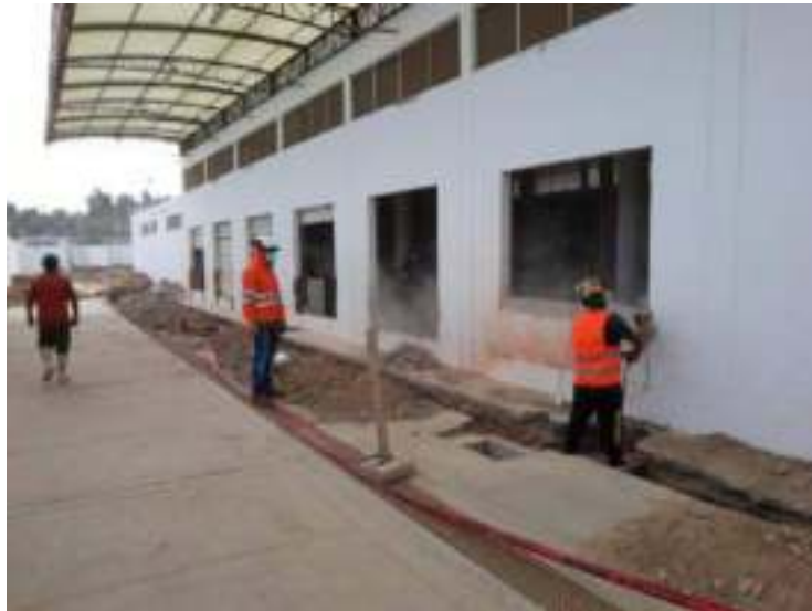
FOTOGRAFIA N° 08 Corte y demolición de concreto para zanja de tubería de desagüe industrial
