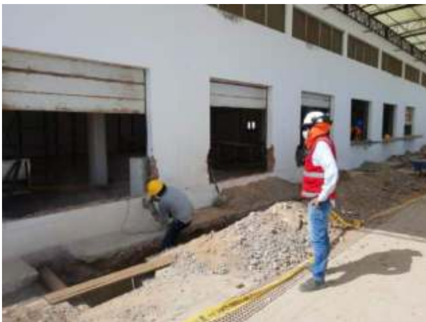
FOTO 05: DEMOLICION DE BASE PARA COLUMNAS
