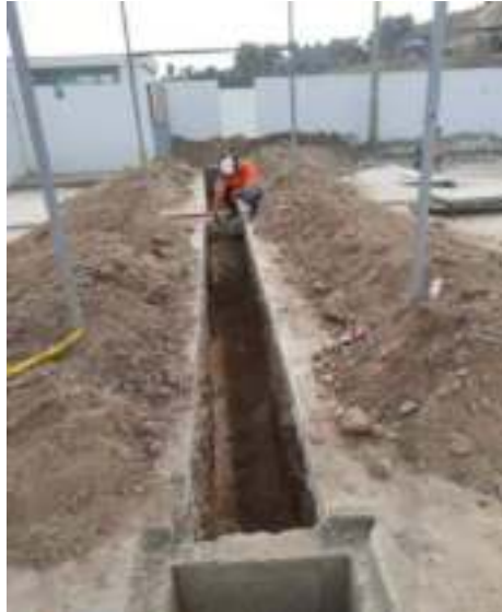
FOTOGRAFIA N° 10 tendido de tubería Pvc 2" ½ agua potable y Tubería Pvc 3" agua salada
