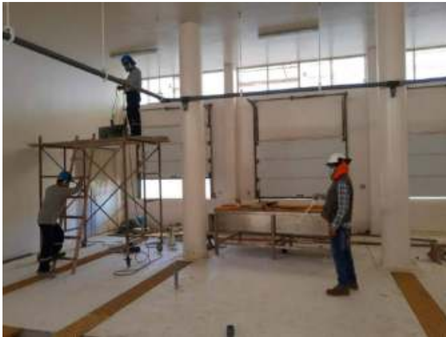
FOTO 05: INSTALACION DE TUBERIAS EN TAREAS PREVIAS
