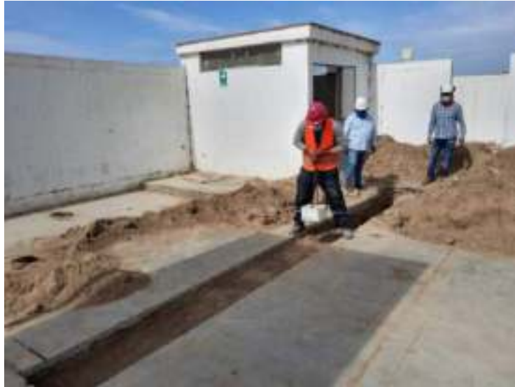
FOTOGRAFIA N° 11 Señalización en obra
