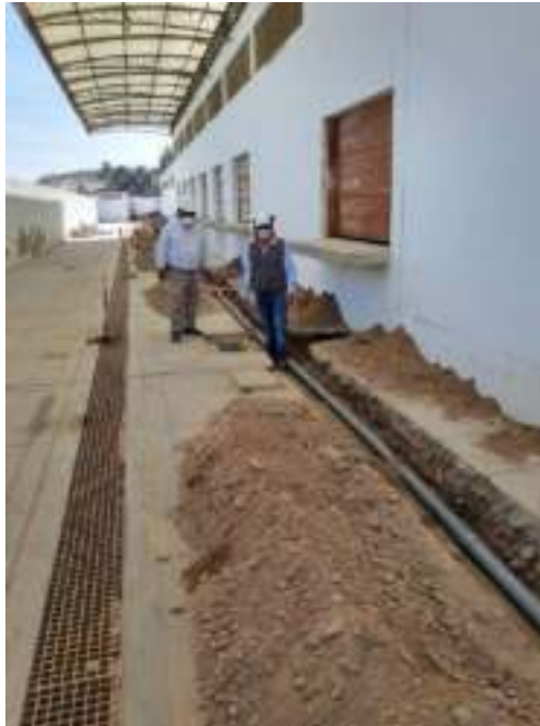
FOTO 05: EXCAVACION Y TENDIDO DE TUBERIAS AGUA FRIA E INDUSTRIAL
