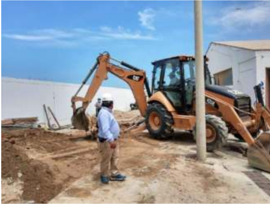
FOTO 04: EXCAVACION DE CUARTO DE BOMBAS
