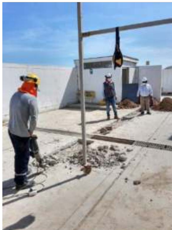
FOTOGRAFIA N° 08 Corte y demolición de concreto para zanja de tubería de desagüe industrial
