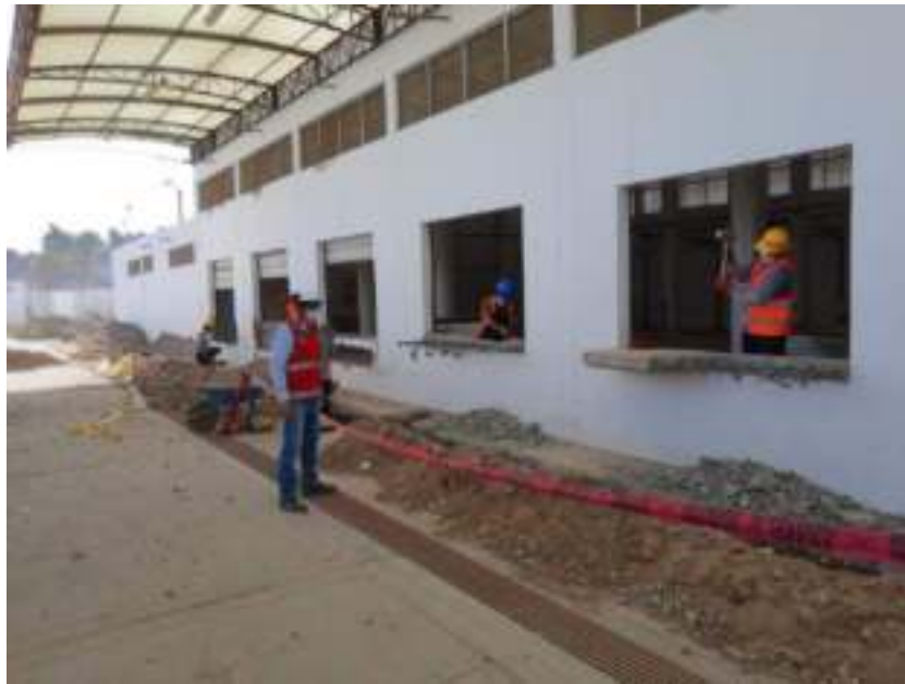
FOTO 05: DEMOLICION DE MENSULAS Y PARED
