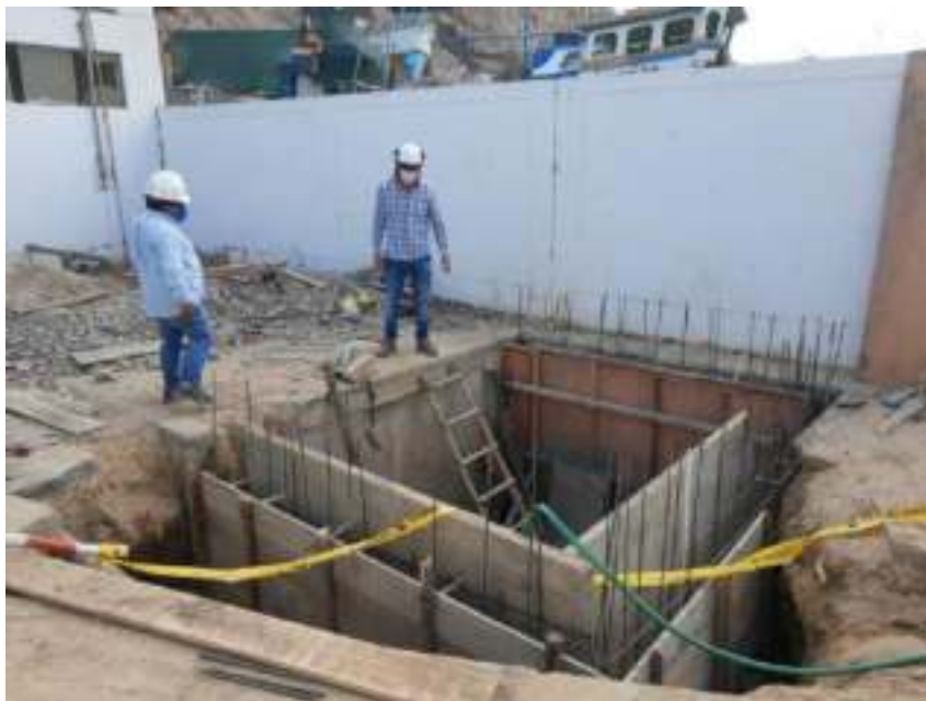
FOTO 03: VACEADO DE CONCRETO CUARTO DE BOMBAS
