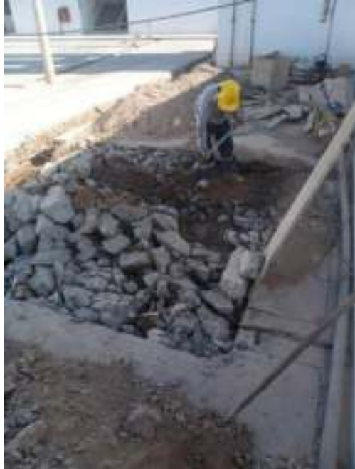
FOTOGRAFIA N° 01: Corte para cuarto de bombas
