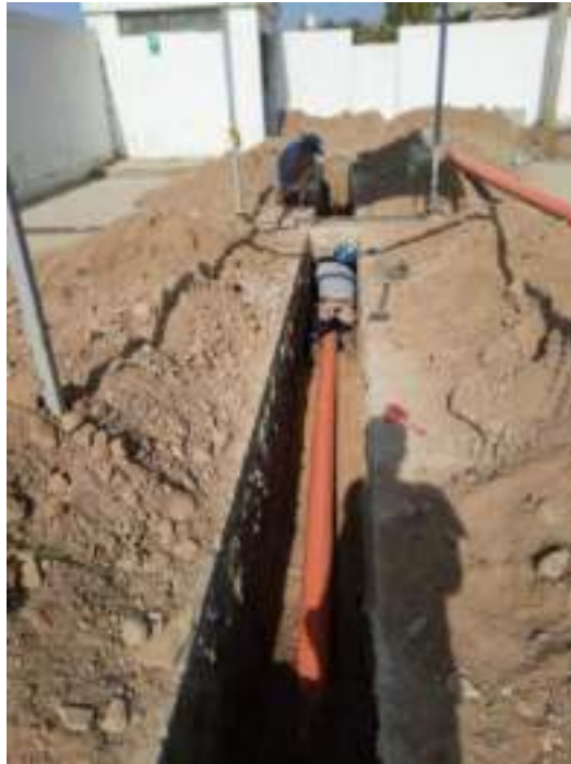
FOTO 05: INSTALACION DE TUBERIAS DESAGUE INDUSTRIAL
