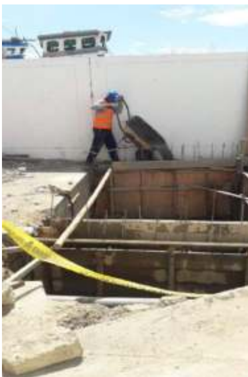
FOTOGRAFIA N° 04: Vaciado de concreto 350 kg/cm 2 para muros
