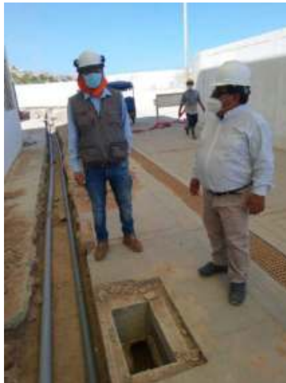
FOTO 06: EXCAVACION Y TENDIDO DE TUBERIAS AGUA FRIA E INDUSTRIAL
