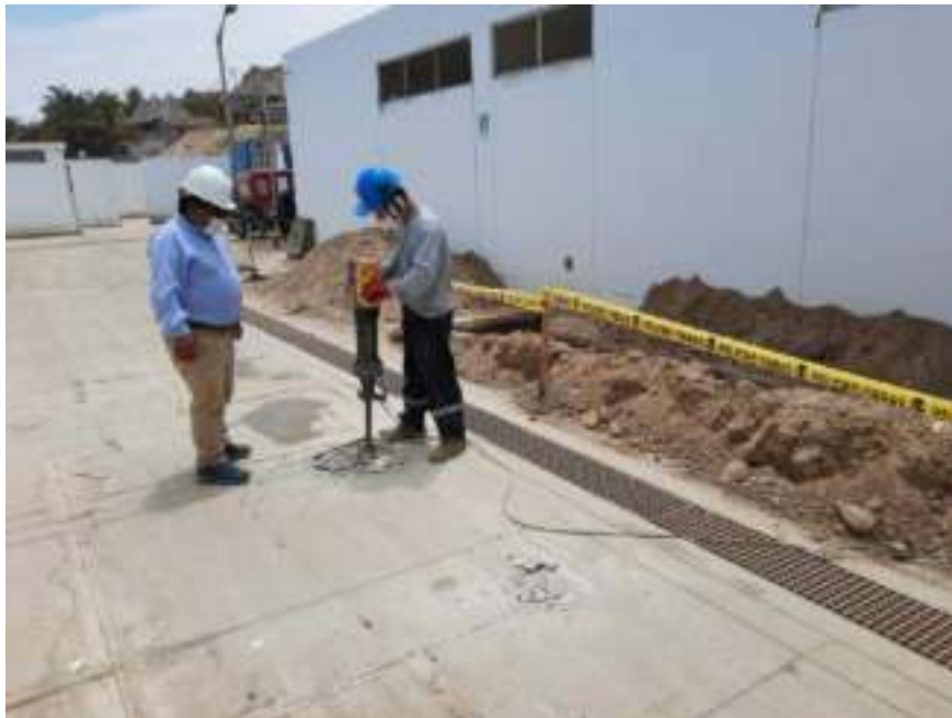
FOTO 03: DEMOLICION DE LOSA TRAMPA DE GRASA
