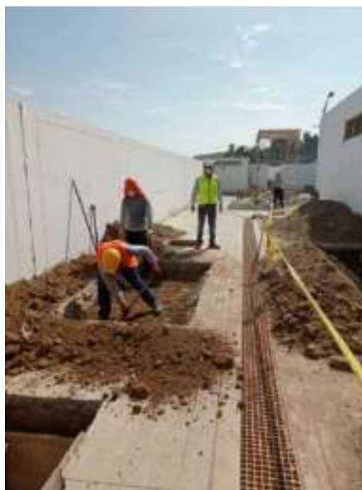
FOTOGRAFIA N° 06 Excavación manual de trampa de grasa
