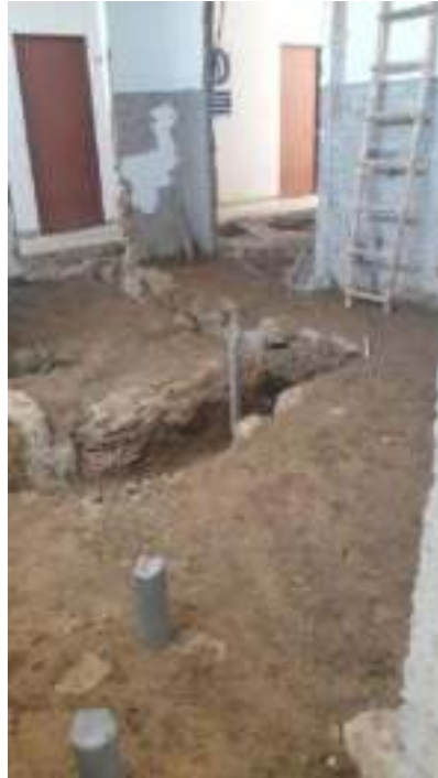
FOTO 03: EXCAVACION CIMENTOS CORRIDOS
