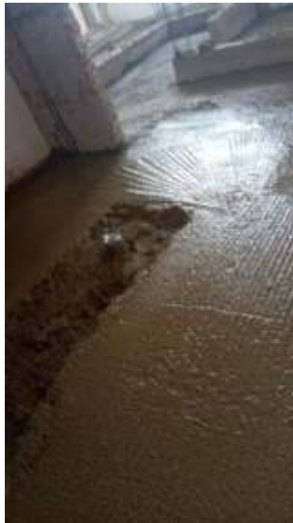
FOTO 04: VERTIDO DE CONCRETO FALSO PISO
