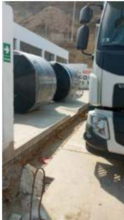
FOTO 05: EXCAVACION DE CANALETAS EXTERIORES
