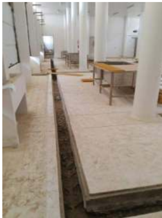
FOTO 06: DEMOLICION DE CANALETAS INTERIORES
