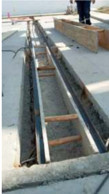
FOTO 05: ENCONFRADO DE CANALETAS EXTERIORES
