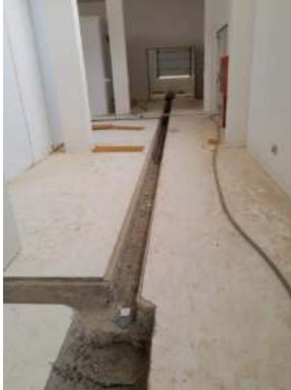
FOTO 05: DEMOLICION DE CANALETAS
