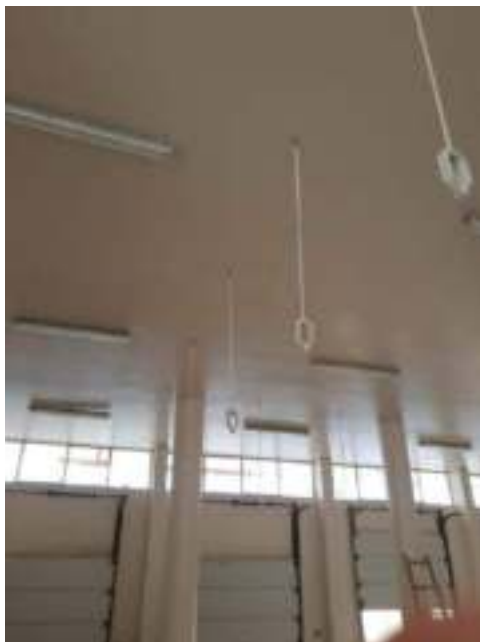
FOTOGRAFIA N° 07 colocación de colgadores metálicos para tubería Pvc en área de tareas
